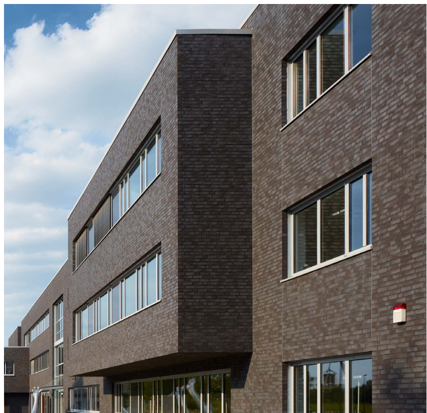
Auf dem Vorplatz fangen auskragende Fassadenteile neugierige Blicke ein.
