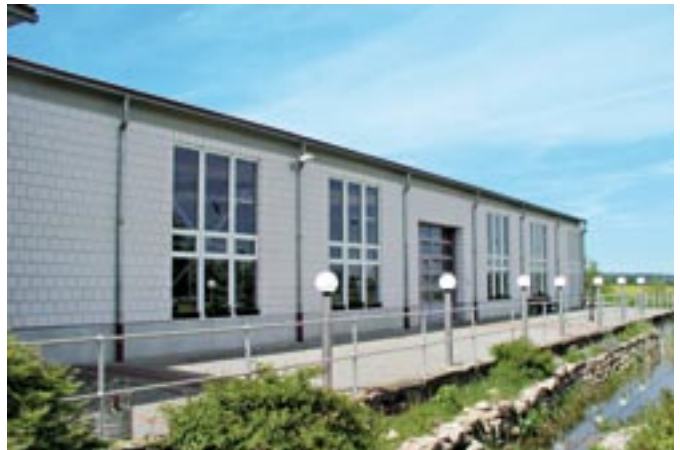
Bürogebäude Fa. Feinauer (1999), 74673 Mulfingen, Außenwand: zweischaliges KS-Mauerwerk, Entwurf: Cordula Feinauer, 74673 Mulfingen-Hollenbach, www.feinauerbaut.de
