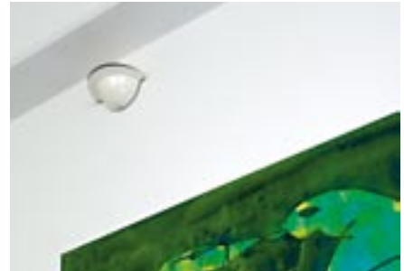
Weitwurfdüse der Lüftungsanlage
