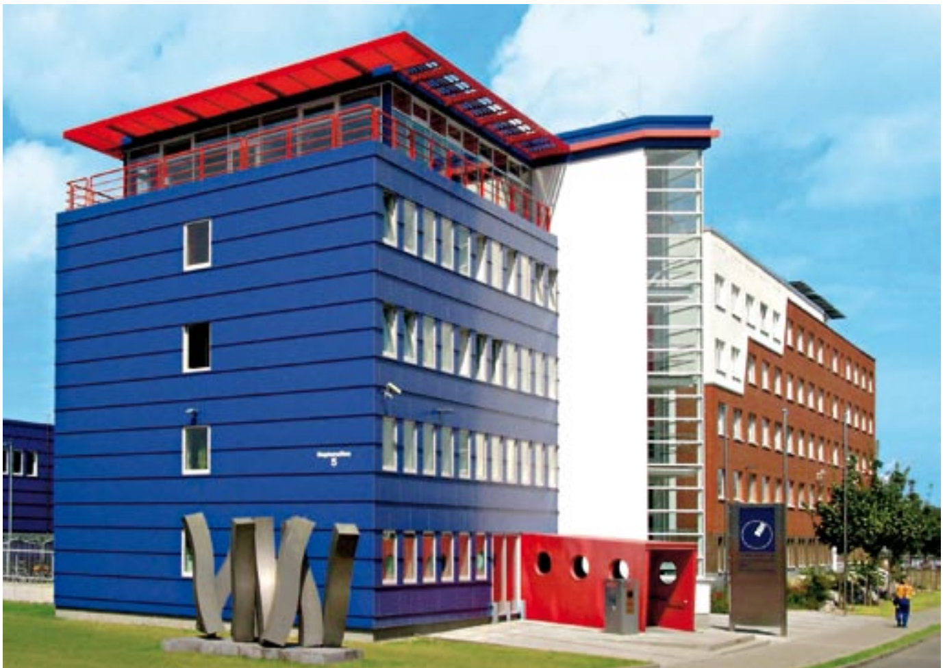
Gebäudeansicht vom Süden: das Bundesamt für Schifffahrt und Hydrographie
