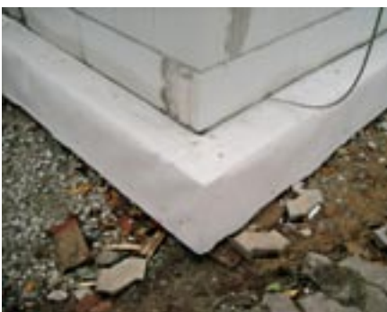
Wärmebrückenfreie Ausführung des Details Bodenplatte – aufgehende Wand
