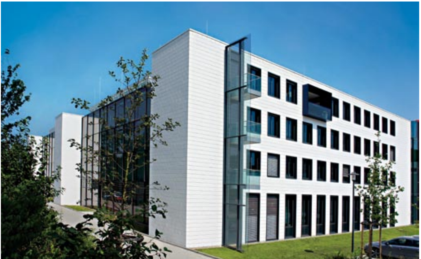
Ansicht Ost: Fraunhofer-Zentrum in Kaiserslautern
