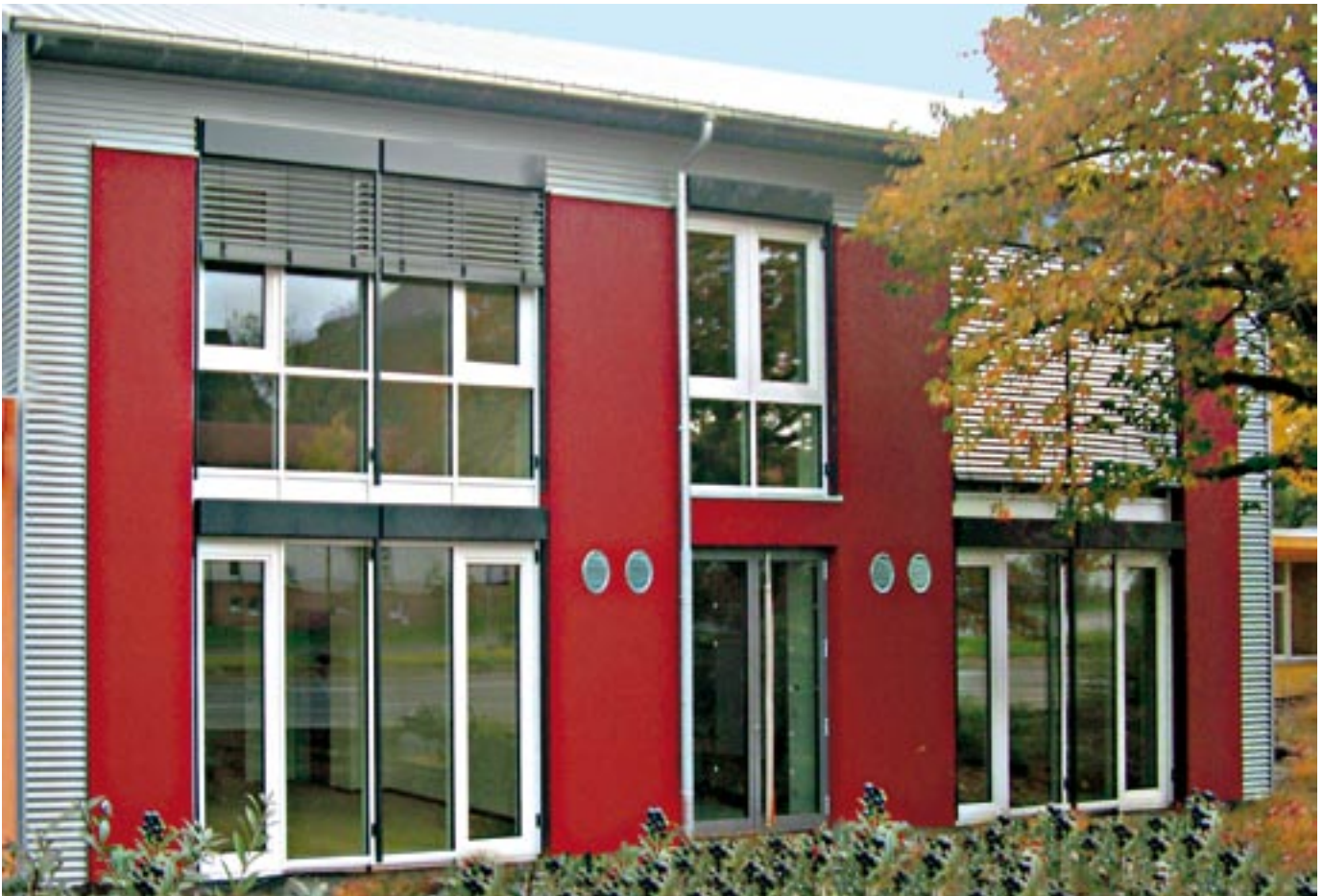
Südwestansicht: Seminar- und Verwaltungsgebäude
