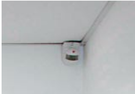
Lüftungsgerät in der Teeküche
