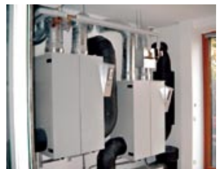
Lüftungsanlage für den Seminarbereich
