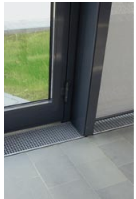
Zulufrost im Innenhofbereich
