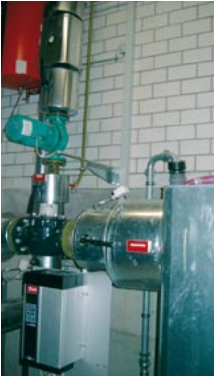
Bild 33: Einfachste Pumpentechnik für die Kühlung mittels Betonkerntemperierung
