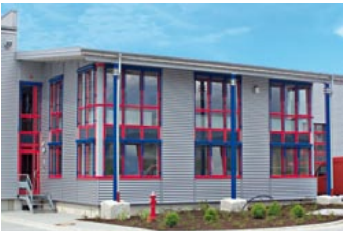
Spedition Schwarz GmbH (2003), 92507 Nabburg, Außenwand: Kalksandstein mit Vorhangfassade (KS+VHF), Entwurf: Dipl.-Ing. Franz Balzer, 92224 Eglsee
