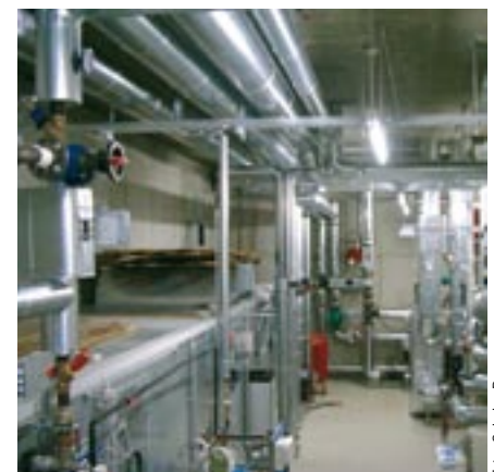
Bild 30: Lüftungszentrale für ein Bürogebäude mit über 5000 m 2 Nutzfläche
