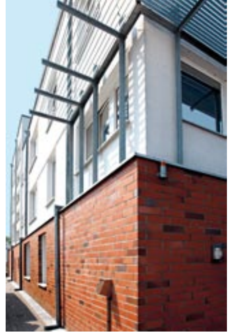
Fassadendetails auf der Hofseite
