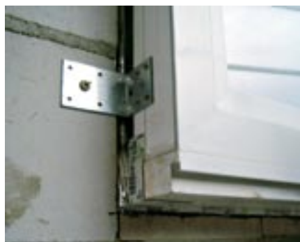
Fensteranschluss vor Anbringen des WDVS
