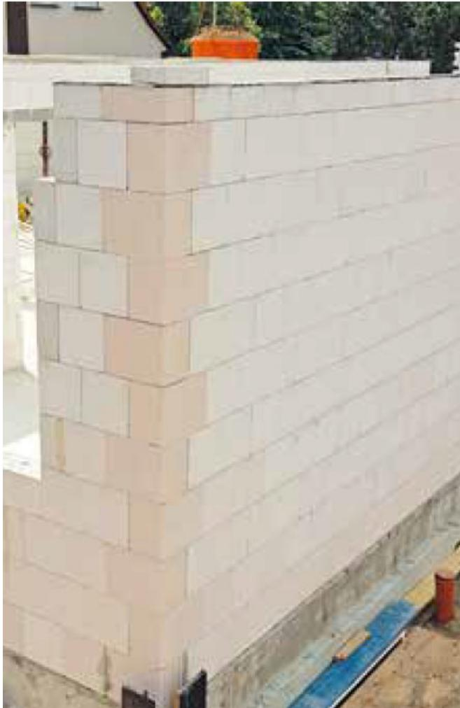
**KS EckVS/175 R(P)-12-1,8.** Mit seiner Länge von  $L = 300$  mm stellen Sie bei einer verzahnten Mauerecke das normgerechte Überbindemas ( $u = 0,4 \times$  Steinhöhe  $248$  mm) sicher – ohne den Stein zu schneiden. Für die Außenecke hat er einseitig eine glatte Stirnseite.
