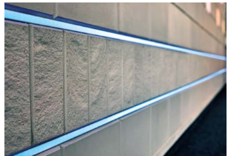
Bild 4 Innensichtmauerwerk aus KS-Fasensteinen kombiniert mit LED-Technik
