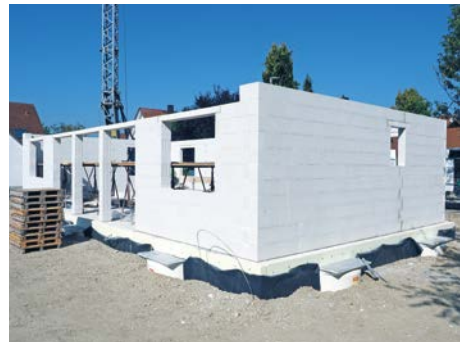
Bild 8 Eine aufgeräumte Baustelle ist die beste Werbung.
