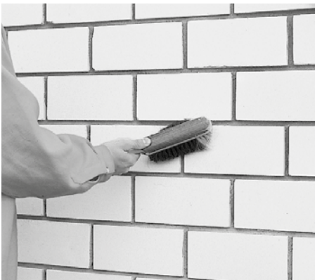
Bild 31 Eventuell vorhandene Mörtelreste sind abzufegen.
