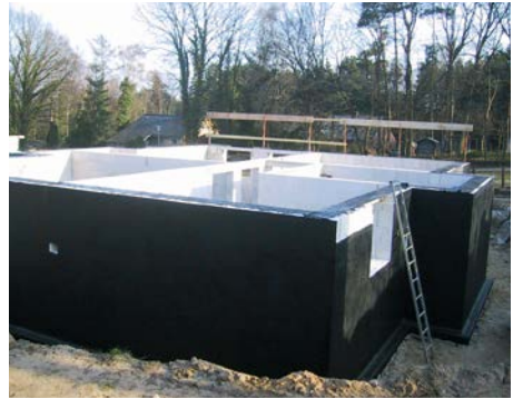
Bild 3 Kellerwand-Außenseite mit PMBC-Abdichtung
