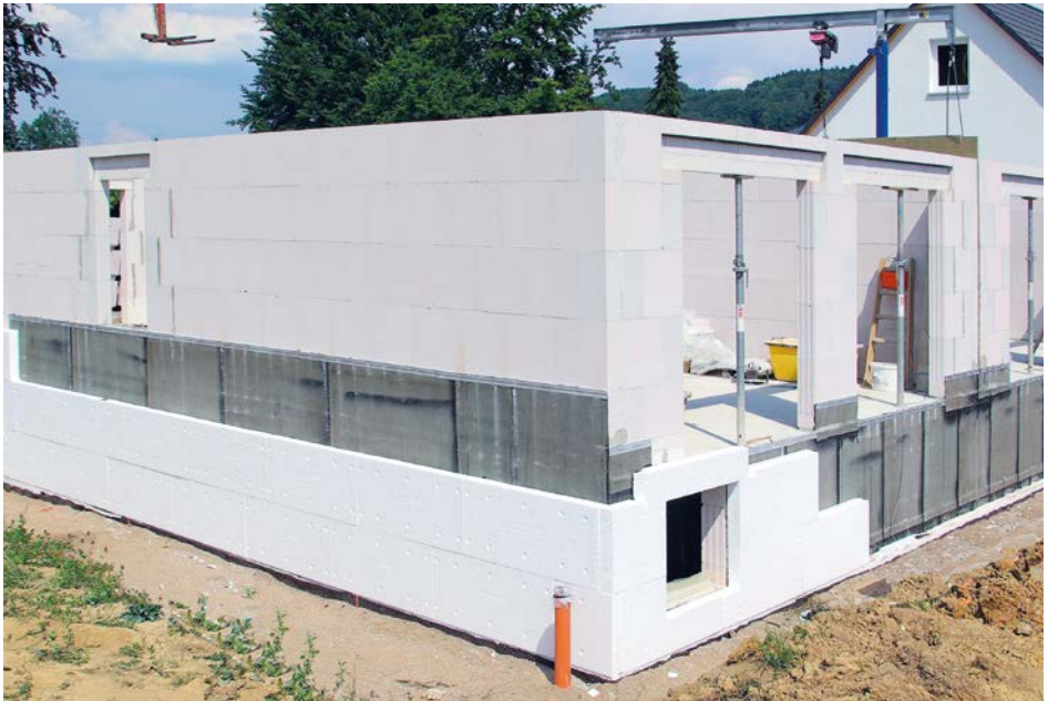
Bild 21 Beispiel einer brandtechnischen Zusatzmaßnahme im Sturzbereich von Wandöffnungen bei EPS-WDVS mit Dämmstoffdicken über 100 mm
