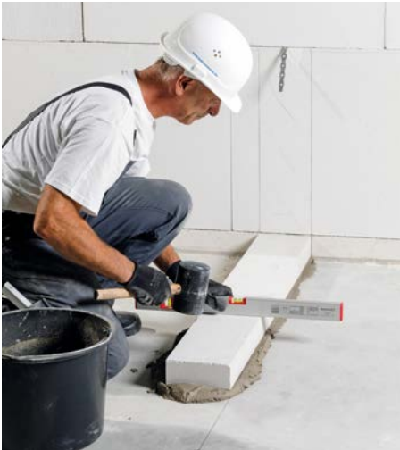
Bild 8 Kimmsteine in Querrichtung ausrichten
