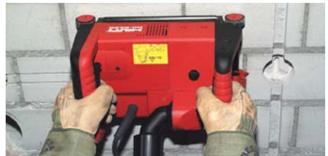
Bild 4 Horizontales Fräsen ist nur in begrenzten Bereichen zulässig.
