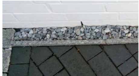
Bild 43 Beispiel für eine Fußpunktausbildung mit Kiesrandstreifen
