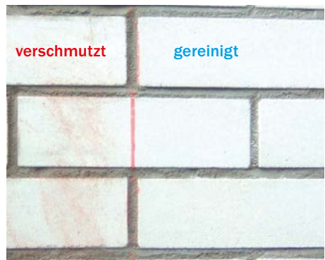
Bild 30 Reinigungseffekt, Beispiel Reinigung mit Schleifpapier, feinste Körnung
