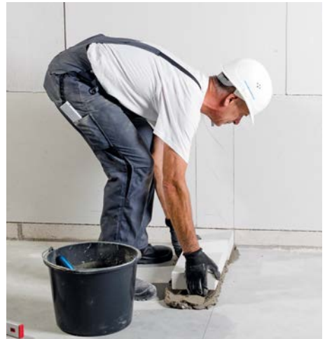
Bild 7 Kimmstein ins Mörtelbett verlegen
