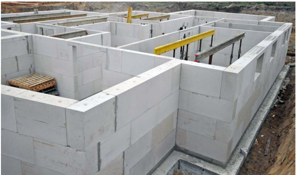
Bild 5 Keller, aus KS XL-Elementen erstellt
