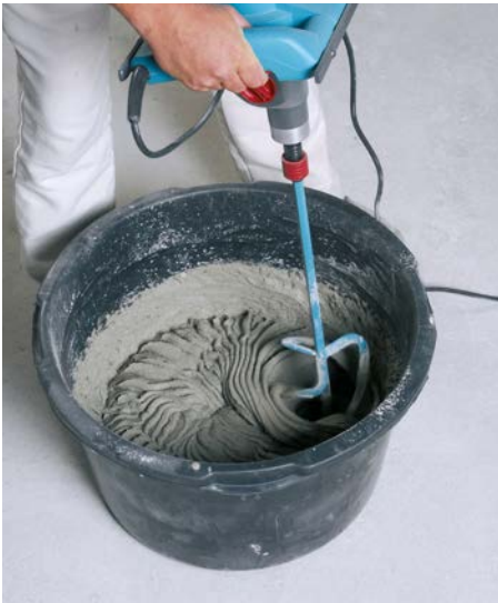
Bild 14 Der Mörtel wird nach Verarbeitungsanweisung gleichmäßig durchgemischt.
