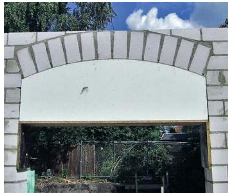
Bild 23 Ausführung eines Flachbogens auf einer Holzschablone
