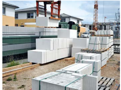
Bild 6 Das Absetzen der Stein stapeln erfolgt zweckmäßig auf Paletten oder Bohlenlege.
