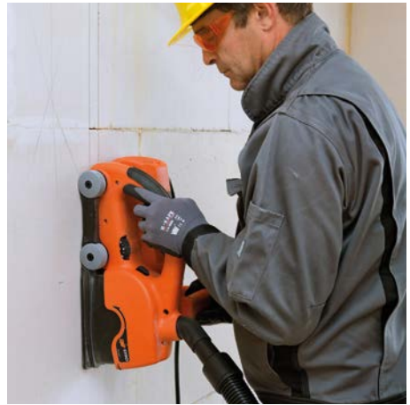
Bild 3 Vertikales Fräsen
