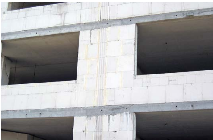
Bild 42 Durch die Außenwand durchgeführte Wohnungstrennwand
