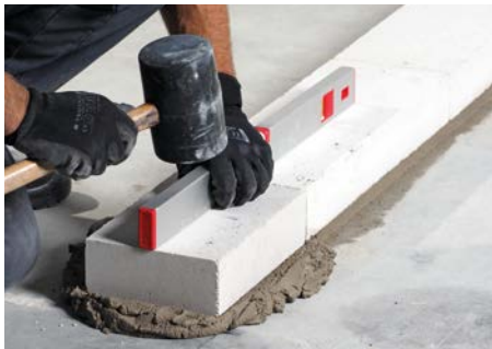
Bild 2 Kontrolle der Ebenheit in Wandlängsrichtung
