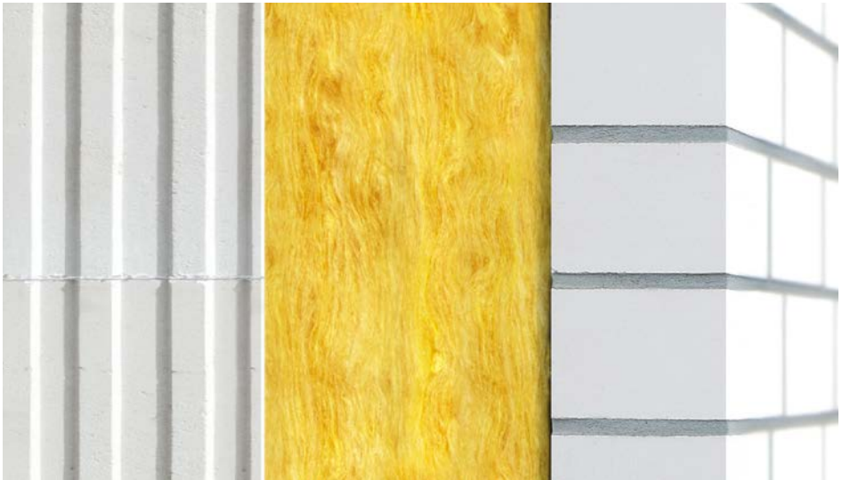
Bild 2 Zweischaliger Wandaufbau mit Hintermauerung, Dämmung und Verblendung
