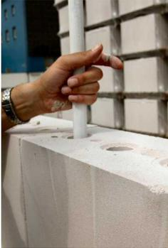
■ Um ein Nachinstallieren in den vertikalen Lochkanälen zu ermöglichen, ist die Lochung am Wandkopf abzudecken, damit beim Betonieren der Decke die E-Kanäle nicht volllaufen. Abdeckung z.B. mit einer besandeten Bitumendachpappe R500 über gesamte Wanddicke oder mittels KS-QUADRO-Abdeckkappen.
