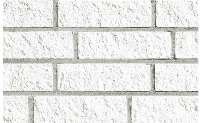
**Bild 2** Sichtmauerwerk aus bruchrauen KS-Verblendern, Format NF
