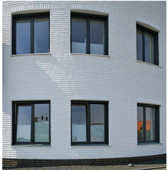
werden in deutlich geringerem Umfang in die Poren der Steine eingespült, sie werden vielmehr vom Regenwasser fortgespült. Damit ist ein gewisser Selbstreinigungseffekt verbunden.
