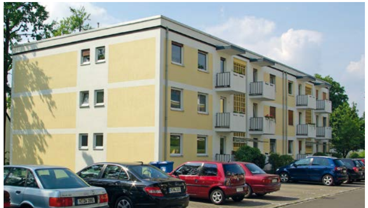
Mehrfamilienhaus aus KS-Mauerwerk und WDVS, Baujahr 1968
