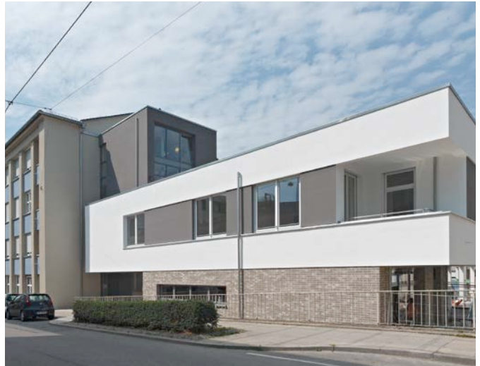
Kalksandstein mit WDVS und Klinkerriemchen im Sockelbereich
