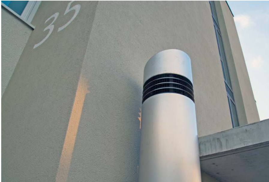
Detail: Zuluft der kontrollierten Wohnraumlüftung
