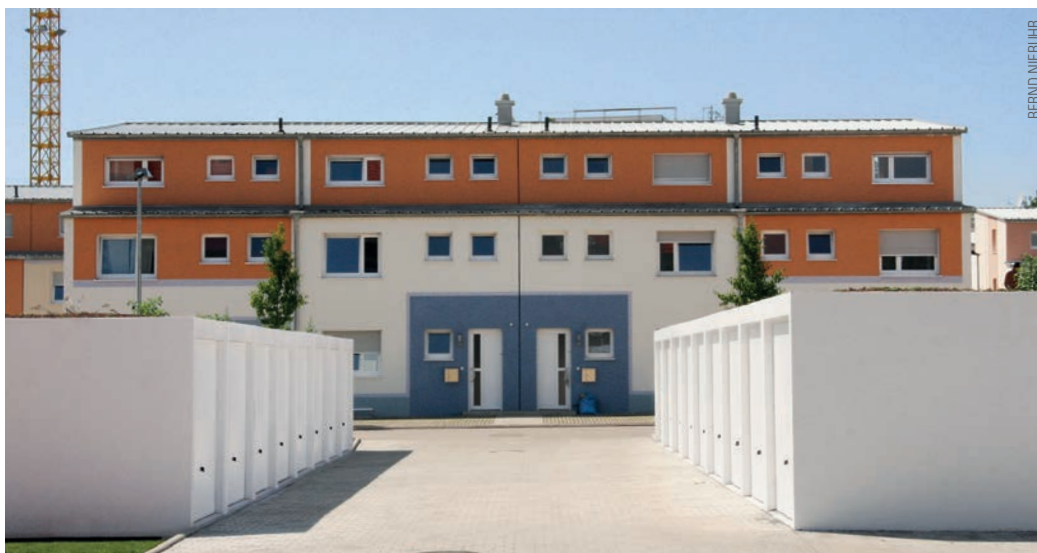
Im Wohnquartier ParkSide kamen als wichtige Schallschutzmaßnahme massive Kalksandsteinwände, Bausystem »KS-Quadro« der Steinrohddichten von bis zu 2,2 kg/dm 3 zum Einsatz.
