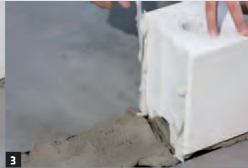
3 Vermörteln der Stoßfuge.
