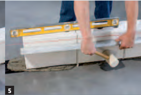
5 Ausrichten der Lage mit Setzlatte.
