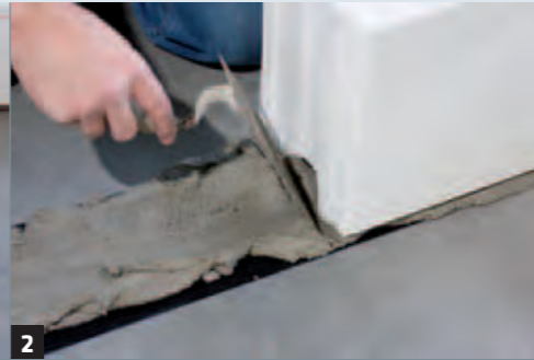
2 Anlegen der ersten Steinschicht in Dickbettmörtel.
