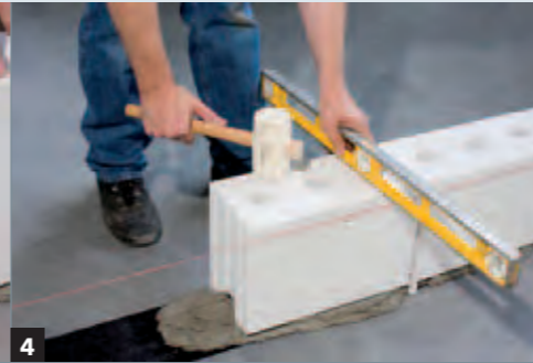
4 Ausrichten des Steins mit Gummihammer und Wasserwaage.
