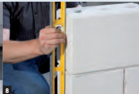
8 Ausrichten der Steine am Wandende.
