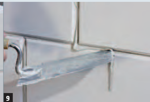
9 Der überschüssige Mörtel wird mit der Kelle abgestrichen.
