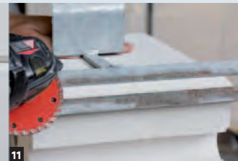
11 Das Anfasen mit der Handfasenlehre und Winkelschleifer empfiehlt sich für kleinere Baustellen.
