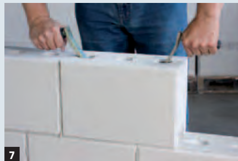
7 Handversetzung des Steins mit Griffhilfen.
