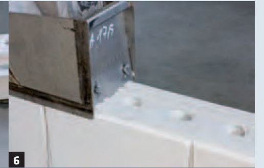
6 Aufziehen des Dünnbettmörtels mit dem Fasenstein-Mörtelschlitten.
