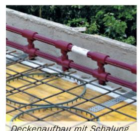
Deckenaufbau mit Schalung
