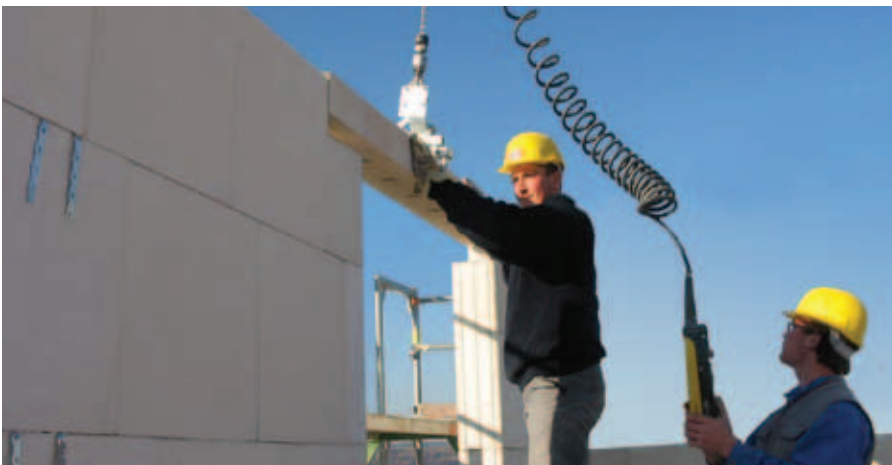
Bild 16: Einbau eines KS-Flachsturzes mit Versetzhilfe.
