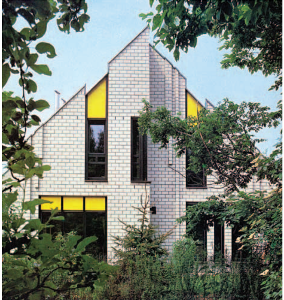
Bild 1: KS-Sichtmauerwerk-Fassade mit eingebauten KS-Sichtmauerstürzen.
