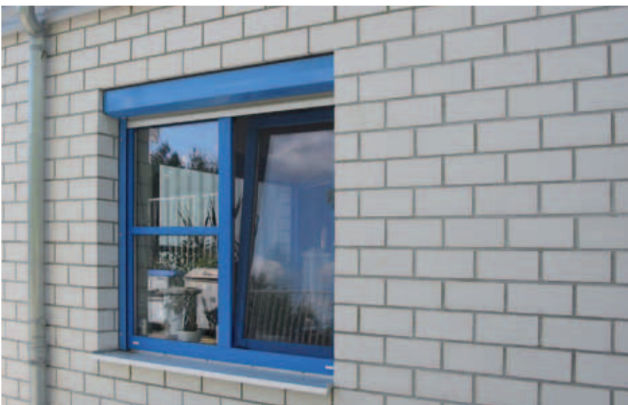
Bild 26: Fassade und KS-Sichtmauersturz bilden eine ästhetische Einheit.
