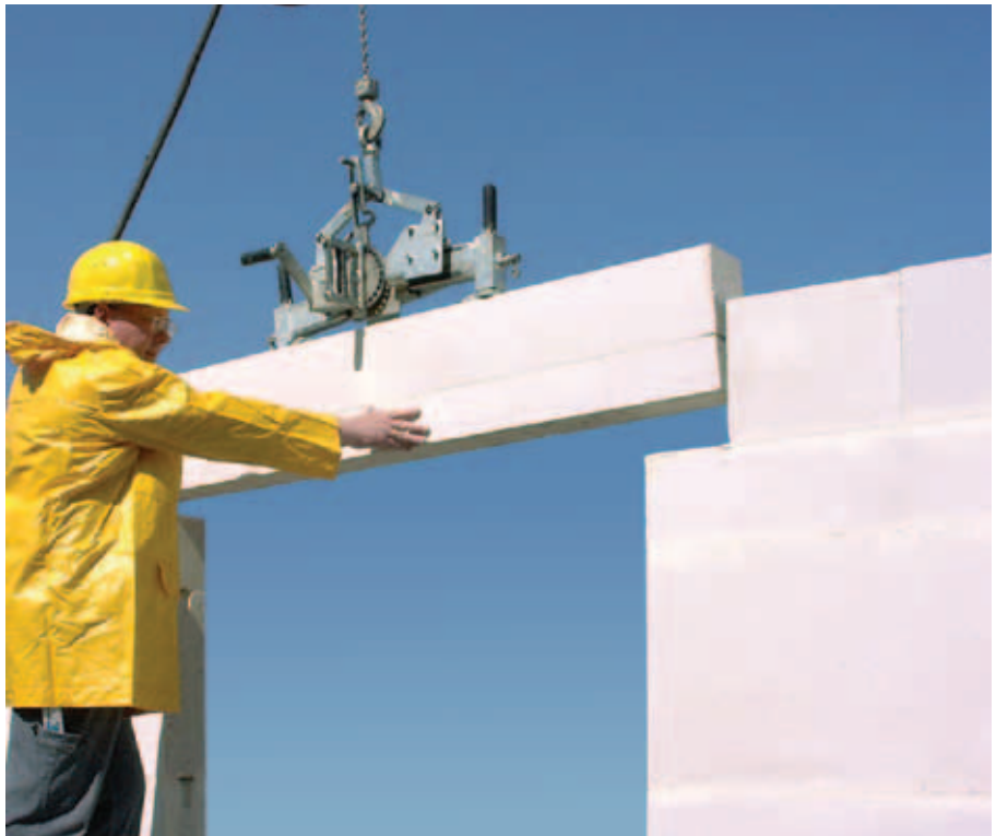
Bild 21: Einbau eines KS-Fertigteilsturzes (FTS) nach abZ Z-17.1-774.
