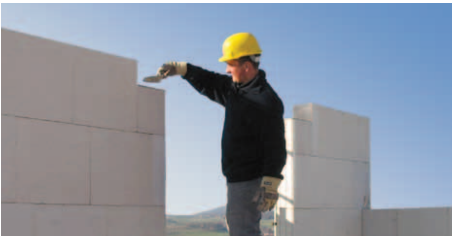
Bild 15: Vorbereiten des Sturzauflegers.
