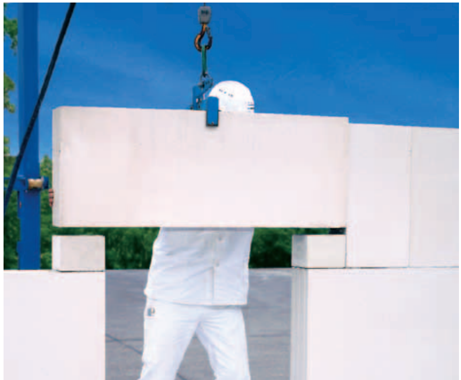
Bild 22: Einbau eines KS-Fertigteilsturzes (FTS) nach abZ Z-17.1-621.
