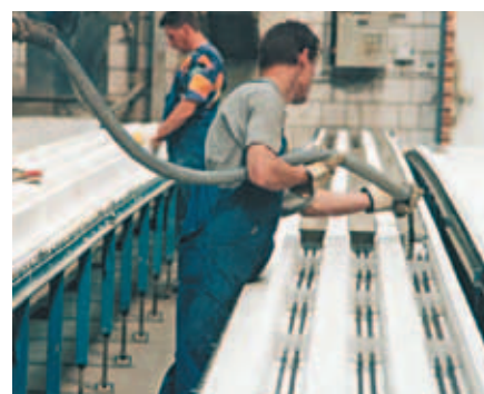
Bild 12: Verfüllen der KS-Sturz-Schalen.
