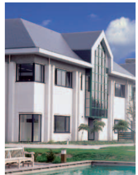
Bild 27: Fassade aus KS-Sichtmauerwerk.
