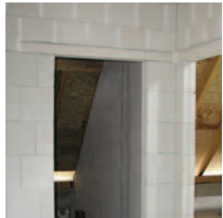
Bild 19: KS-Flachsturz mit vermörtelten Stoßfugen in der Übermauerung (Druckzone).
