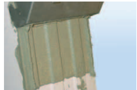
Bild 18: Stoßfugenvermörtelung mit einer geeigneten Stoßfugenkelle.
