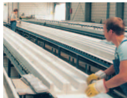
Bild 11: Ausrichten der KS-Sturz-Schalen.
