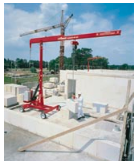
Bild 25: Arbeiten mit dem Versetzgerät
