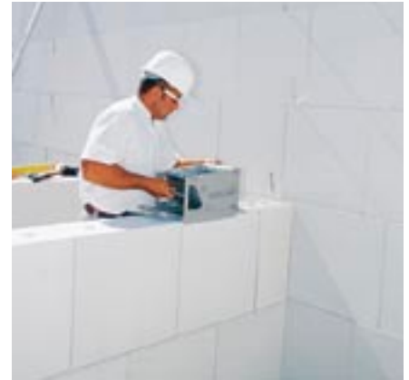
Bild 24: Nächste Steinlagen aufmauern
