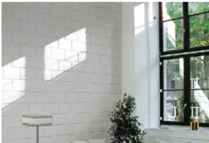
Bild 7: Innensichtmauerwerk aus KS-Fasensteinen, weiß gestrichen
