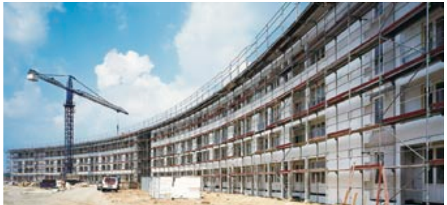
Bild 3: Wirtschaftliches Bauen mit großformatigen Kalksandsteinen
