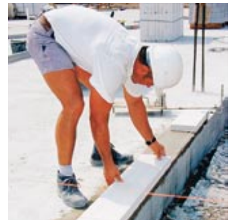
Bild 18: Kimmsteine im Mörtelbett verlegen
