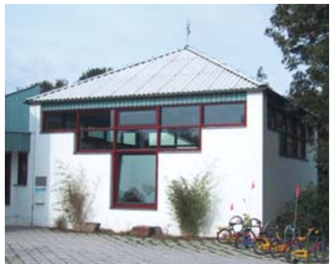
Bild 2: Einfarbig gestrichenes KS-Verblendmauerwerk
