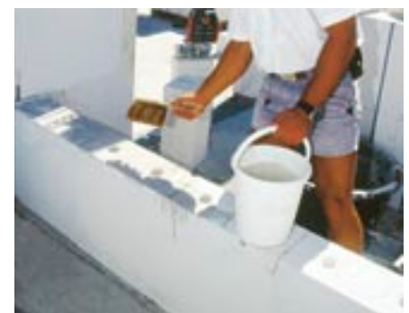
Bild 14: Bei sehr trockenen Steinen sind diese vorzunässen.
