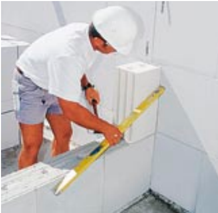
Bild 22: Ausrichten des Steins
