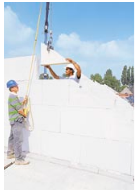
Bild 12: Vermauern von KS XL-Planelementen
