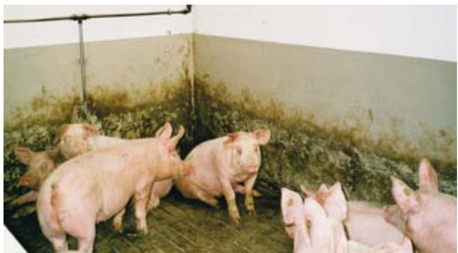
Bild 70: Beschichtetes bzw. gestrichenes KS-Mauerwerk erleichtert die Reinigung.
