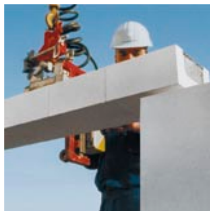
Bild 14: Vorgefertigte KS-Flachstürze zur schnellen und rationellen Öffnungsüberdeckung
