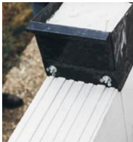
Bild 4: Mörtelauftrag mit Mörtelschlitten
