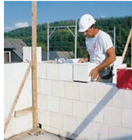
Bild 5: Versetzen von Plansteinen in Dünnbettmörtel
