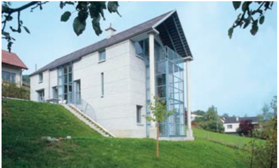
Bild 26: Sichtmauerwerk aus KS-Verblendern, farblos imprägniert
