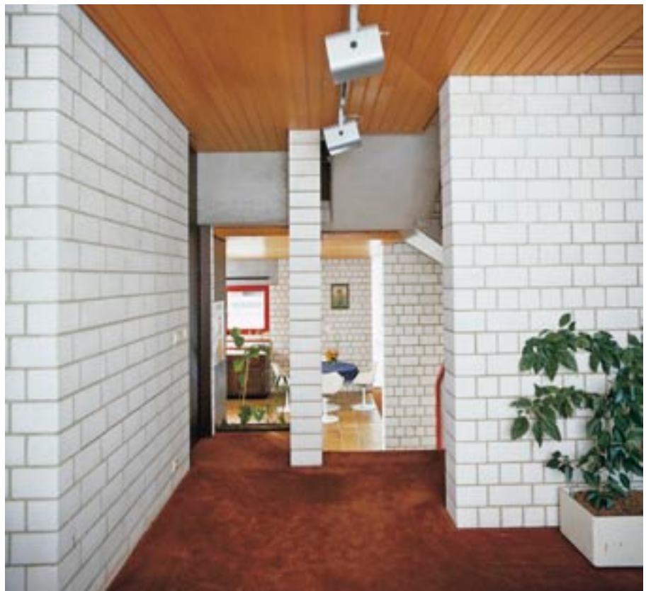
Bild 15: Im Innenbereich sind Kalksandsteinwände mit Sichtmauerwerk Gestaltungselement.
