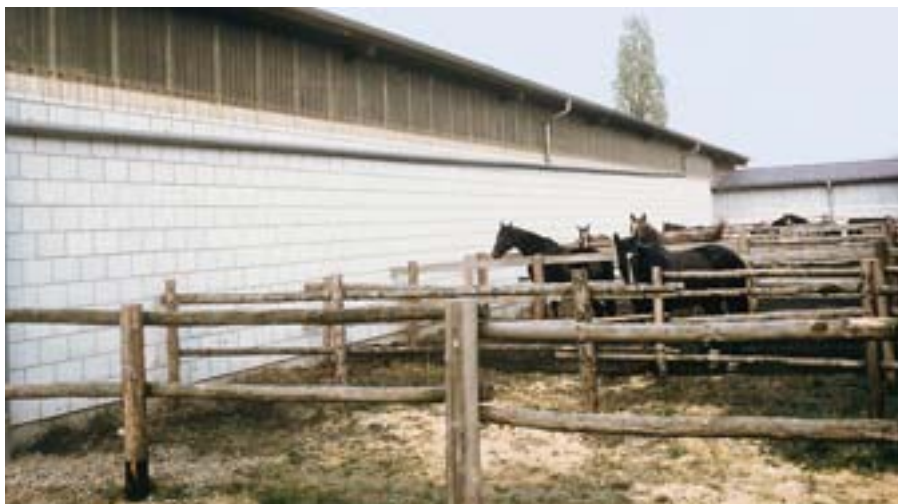
Bild 72: Einschalige KS-Außenwand bei einem Reitstall
