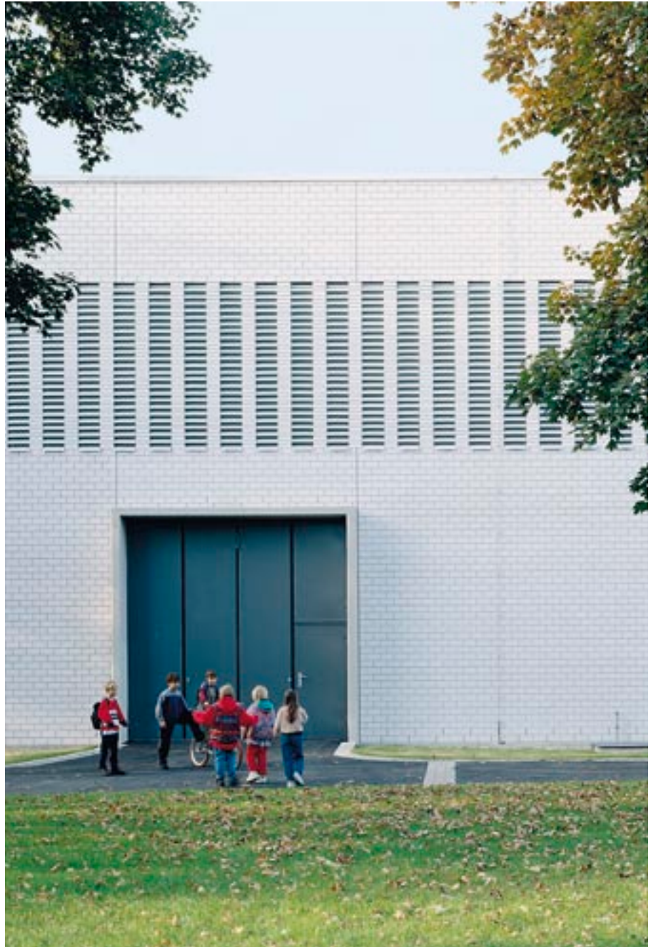
Bild 28: Sichtmauerwerk aus KS-Verblendern, farblos imprägniert, im Industriebau
