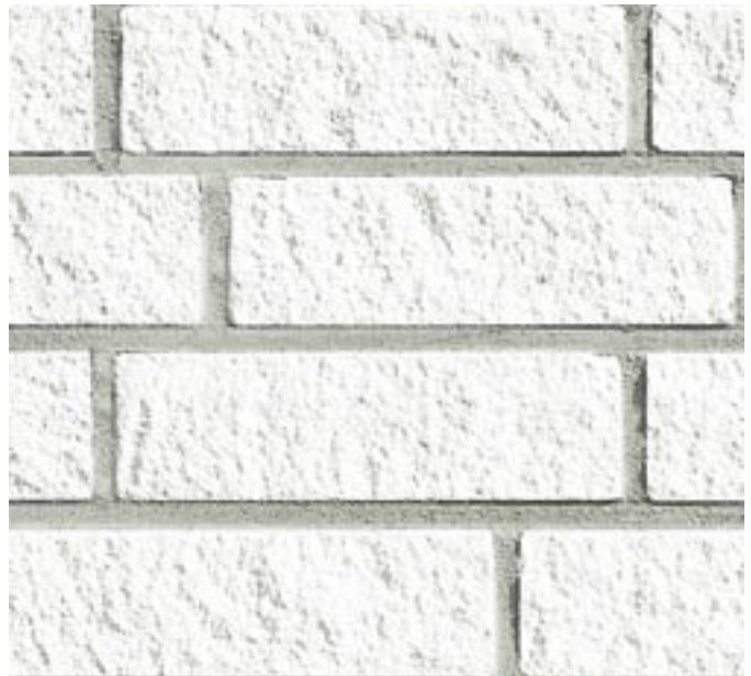
Bild 4: Sichtmauerwerk aus bruchrauen KS-Verblendern, Format NF
