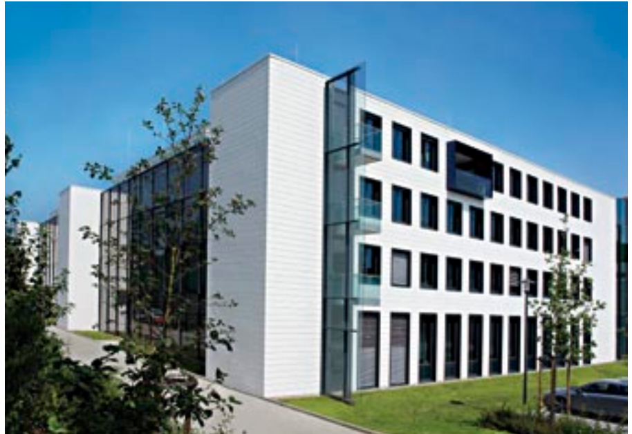
Bild 22: Sichtmauerwerk aus KS-Verblendern, farblos imprägniert, mit hellem Fugenmörtel
