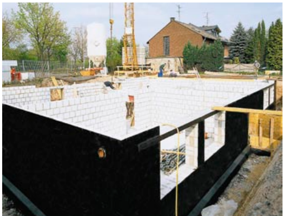
Bild 1: Kellerwände aus KS-Mauerwerk mit kunststoffmodifizierter Bitumendickbeschichtung (KMB)
