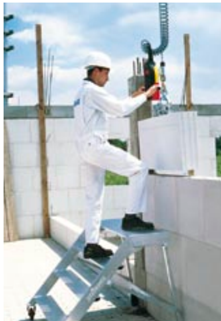
Bild 11: Vermauern von KS XL-Rasterelementen
