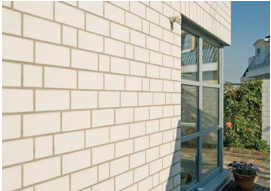
Bild 23: Sichtmauerwerk setzt in Verbindung mit modernen Fensterelementen Akzente.
