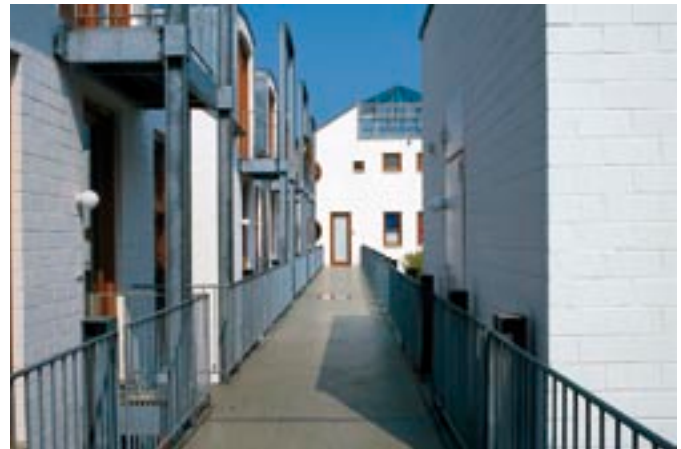
Bild 12: Sichtmauerwerk aus KS-Verblendern im Format 2 DF, weiß gestrichen
