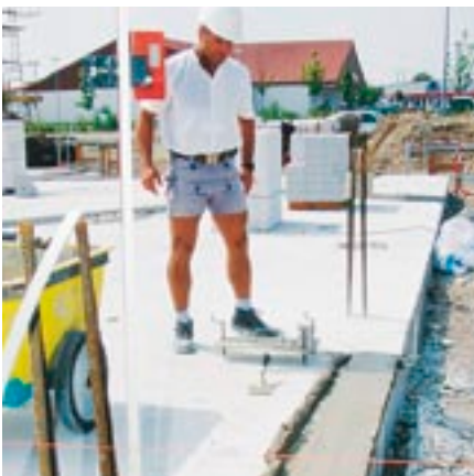
Bild 16: Mörtel für die Kimmschicht aufziehen
