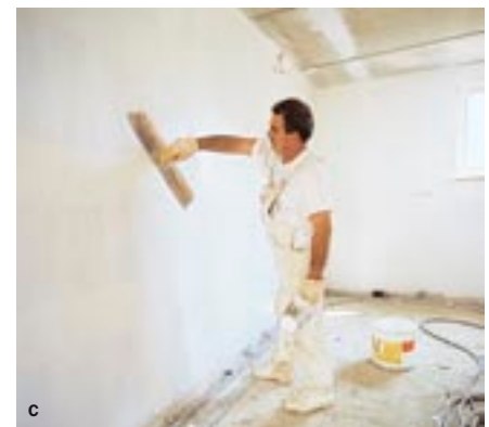
Bild 12: Arbeitsschritte beim Verputzen einer Wand; a: Abspachteln der Stoß- und Lagerfugen bei Dünnlagenputz; b: Auftrag des Putzmörtels; c: Glätten des Putzes
