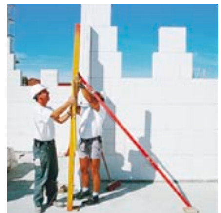
Bild 15: Mauerlehren zur Vereinfachung und Beschleunigung des Bauablaufs
