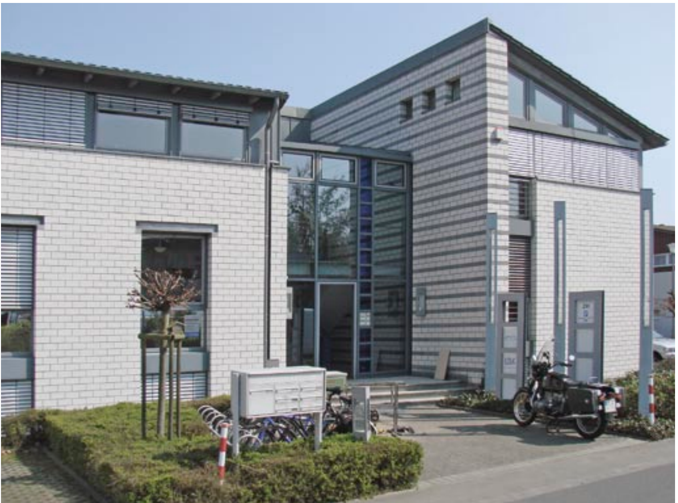
Bild 27: Gebäudeensemble aus Sichtmauerwerk in Kalksandstein
