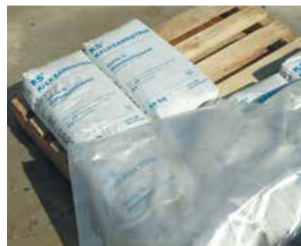
Bild 2: Werk-Trockenmörtel ist vor Witterungseinflüssen zu schützen.
