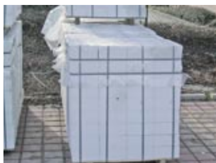
Bild 13: Lagern von Steinen mit Schutz gegen Niederschlag
