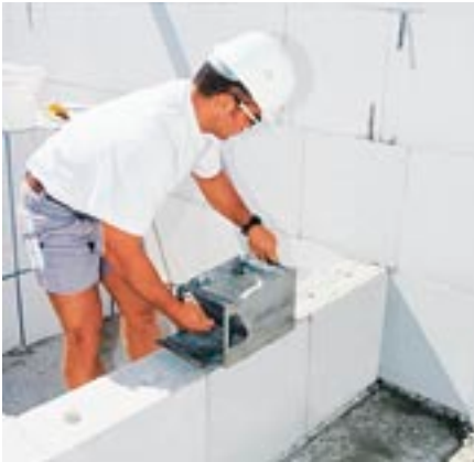
Bild 19: Lagerfugenmörtel mit Mörtelschlitten aufziehen
