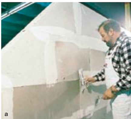
Bild 12: Arbeitsschritte beim Verputzen einer Wand; a: Abspachteln der Stoß- und Lagerfugen bei Dünnlagenputz; b: Auftrag des Putzmörtels; c: Glätten des Putzes
