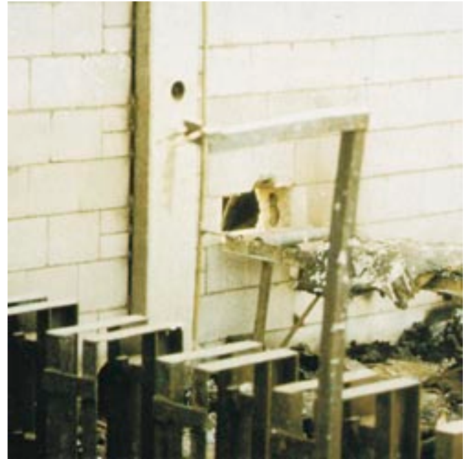
Bild 27: Brandwand mit nicht ordnungsgemäß ausgeführten Verschlüssen nach einem Brandereignis
