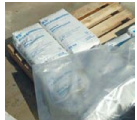
Bild 9: Der Werk-Trockenmörtel ist vor Witterungseinflüssen zu schützen.
