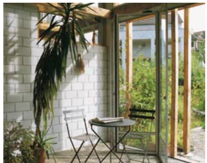
Bild 2: Innensichtmauerwerk aus KS-Verblendern
