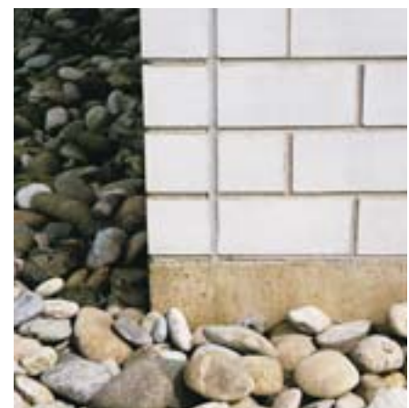
Bild 16: Ausführung einer Dehnungsfuge an einer Gebäudekante mit spritzbarem Fugendichtstoff
