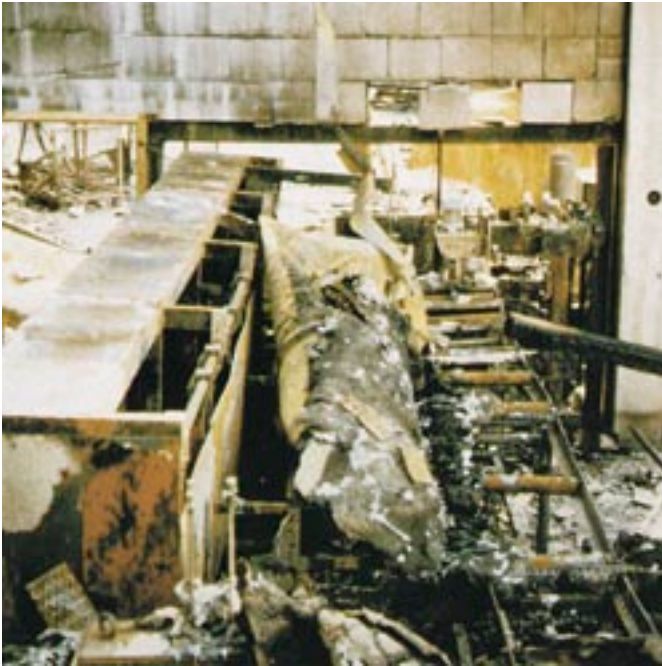
Bild 27: Brandwand mit nicht ordnungsgemäß ausgeführten Verschlüssen nach einem Brandereignis
