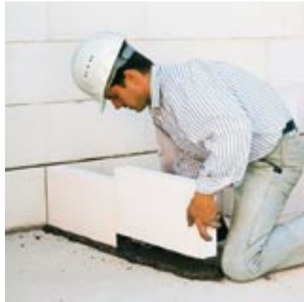
Bild 11: Die erste Steinreihe wird in Normalmauermörtel versetzt.
