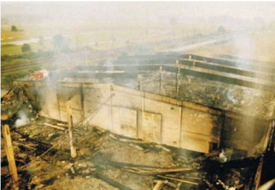
Bild 22: Brandwand mit einem nicht ordnungsgemäß ausgeführten Dachanschluss sowie fehlenden Verschlüssen im Bereich der Lüftung nach einem Brandereignis
