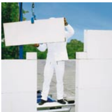
Bild 13: KS-Fertigteilstürze für großformatiges Mauerwerk
