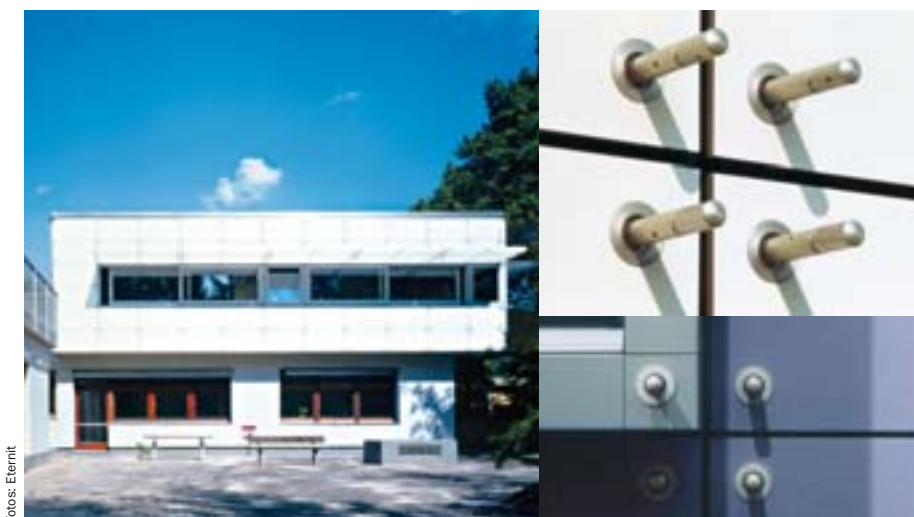
Bild 66: VHF mit großformatigen Faserzementplatten
