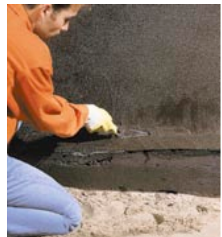
Bild 11: Glattziehen der Hohlkehle mit der Zungenkelle
