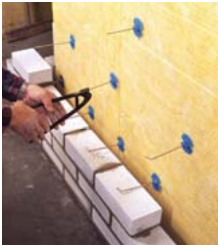
Bild 11: Dübelanker mit Klemm- und Abtropfscheibe im eingebauten Zustand (links) und als Prinzipskizze (rechts)
