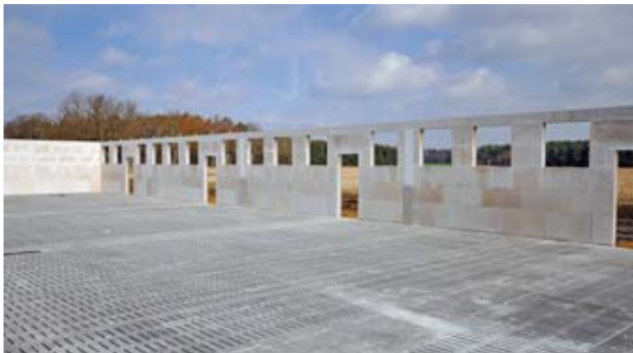
Bild 71: Rohbau eines Maststalls
