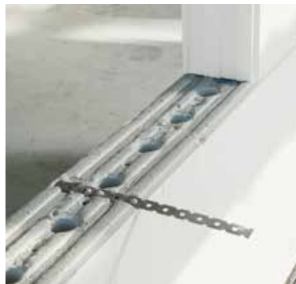
Bild 35: Mörtelbett mit Edelstahl-Flachanker
