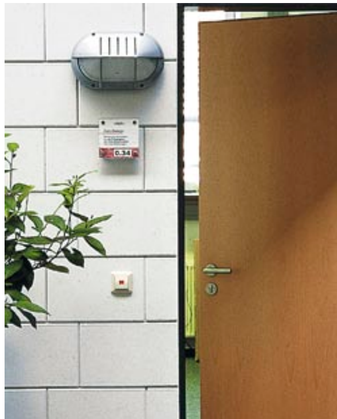
Bild 20: Innensichtmauerwerk aus KS-Fasensteinen, Installationen verdeckt in Kanälen
