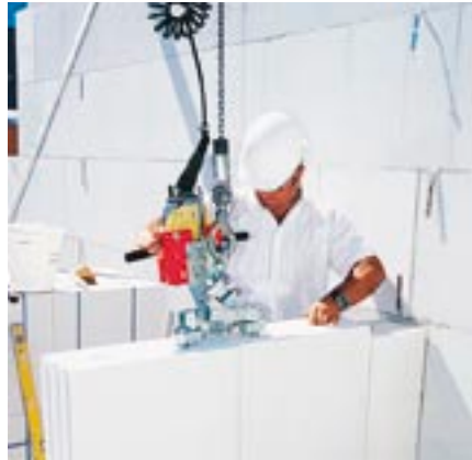
Bild 23: Versetzen der folgenden Steine
