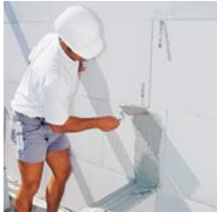
Bild 20: Mörtel für Anschlussfuge auftragen
