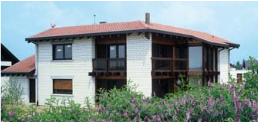
Bild 6: Sichtmauerwerk aus KS-Verblendern, Format 2DF
