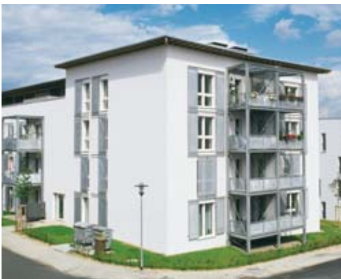
Bild 1: Außenwand mit Wärmedämm-Verbundsystem
