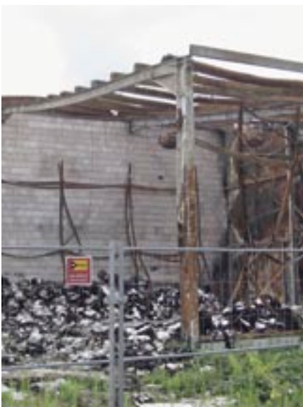
Bild 16: Durch Brand verformte Stahlkonstruktion vor unversehrter Kalksandsteinwand
