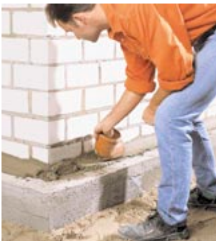
Bild 9: Herstellen der Hohlkehle, Querschnittsabdichtung mit Dichtschlämme
