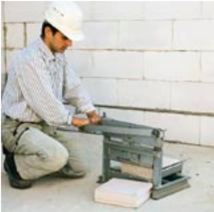
Bild 10: Pass-Stücke werden vor Ort hergestellt.
