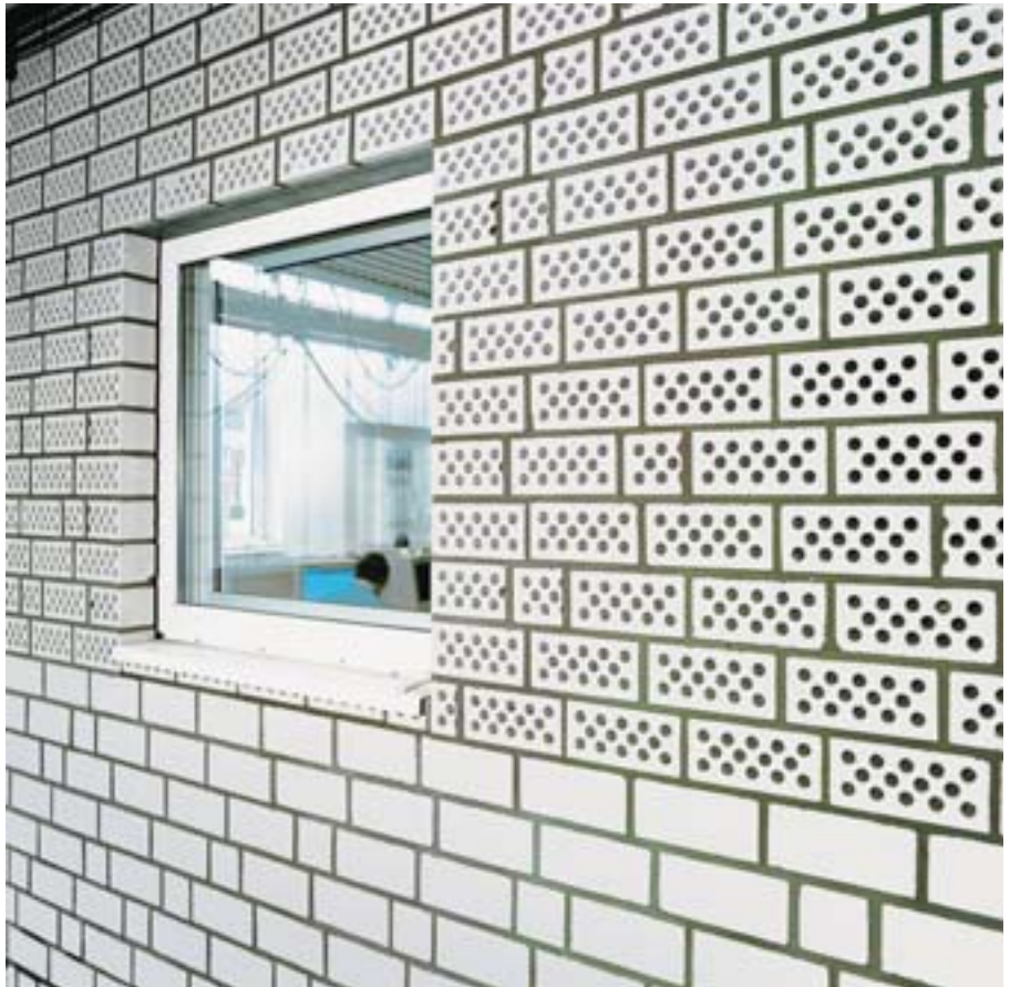
Bild 44: Schallschluckwand aus KS-Schallschlucksteinen (Lochsteine, werkseitig durchstoßen)
