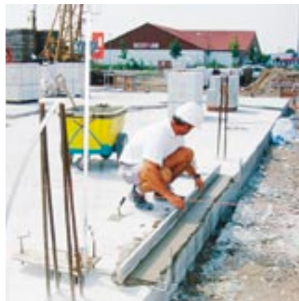
Bild 17: Mörtel planeben abziehen
