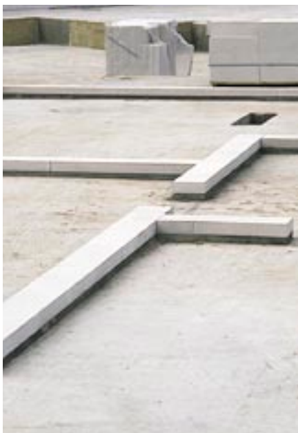
Bild 10: Anlegen der Kimmschicht
