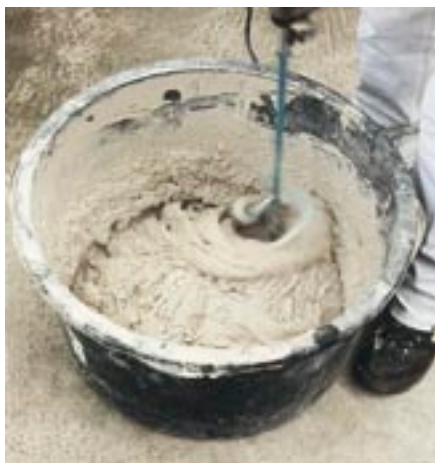
Bild 3: Mischen von Dünnbettmörtel
