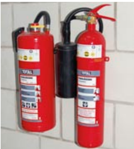
Bild 1: Befestigung von Feuerlöschern
