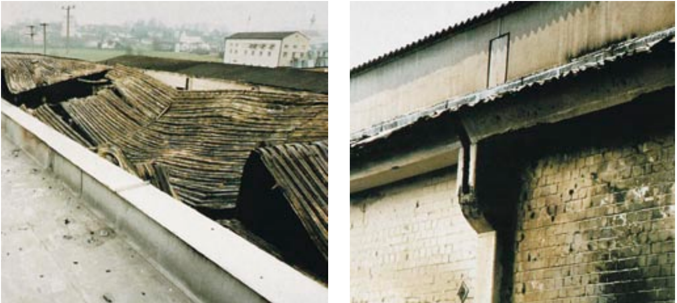
Bild 21: KS-Brandwand nach einem Brandereignis mit richtigem Dachanschluss
