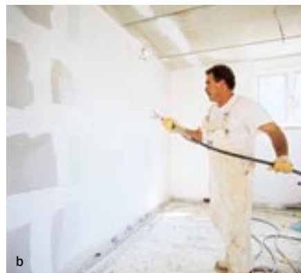
Bild 12: Arbeitsschritte beim Verputzen einer Wand; a: Abspachteln der Stoß- und Lagerfugen bei Dünnlagenputz; b: Auftrag des Putzmörtels; c: Glätten des Putzes
