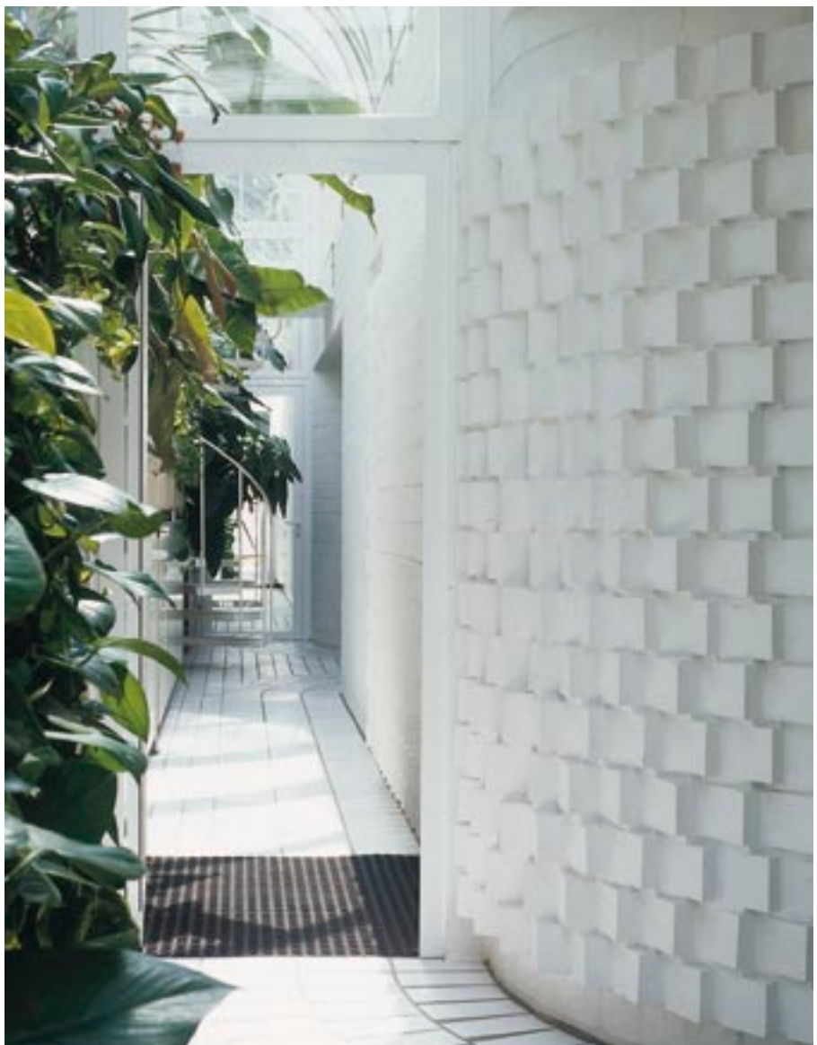
Bild 27: Innensichtmauerwerk aus KS-Steinen
