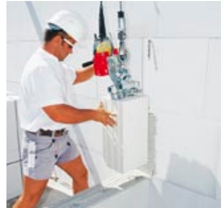
Bild 21: Ersten Stein setzen
