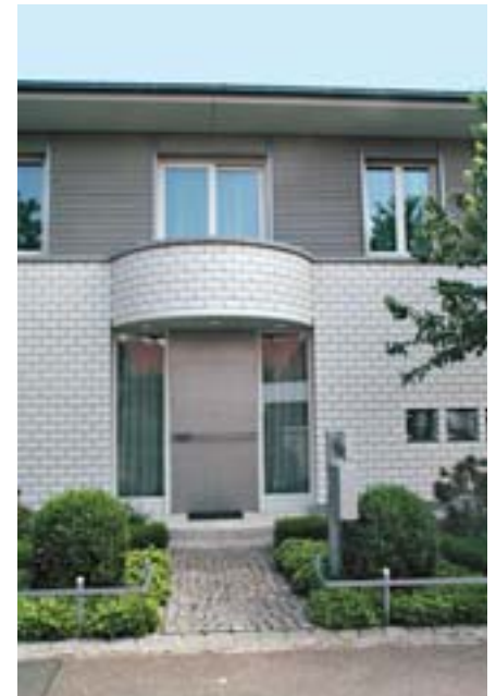
Bild 42: Sichtmauerwerk aus KS-Verblendern kombiniert mit vorgehängter hinterlüfteter Fassade
