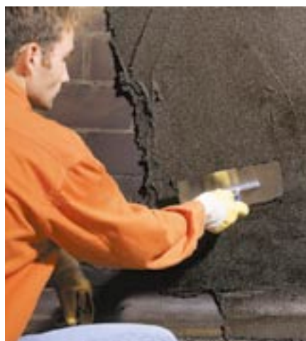
Bild 10: Aufziehen der kunststoffmodifizierten Bitumendickbeschichtung mit der Glättkelle
