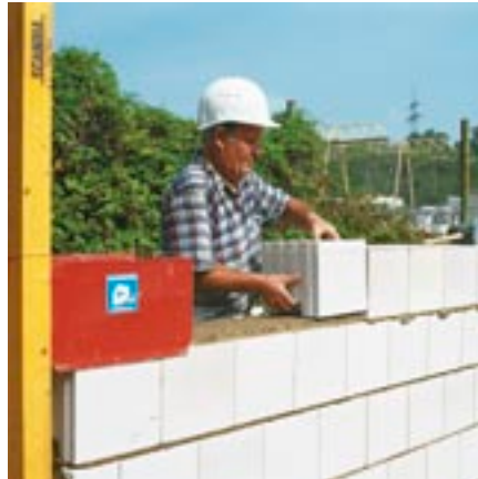
Bild 4: KS -R-Blocksteine für Normalmauermörtel
