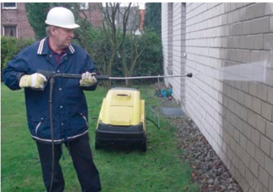
Bild 24: Reinigung mit Hochdruckreiniger
