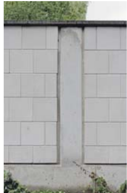
Bild 73: Frei stehende KS-Wand mit Aussteifungen
