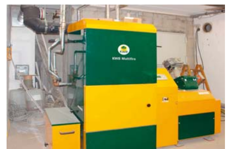
Technikzentrale mit Pelletsessel
