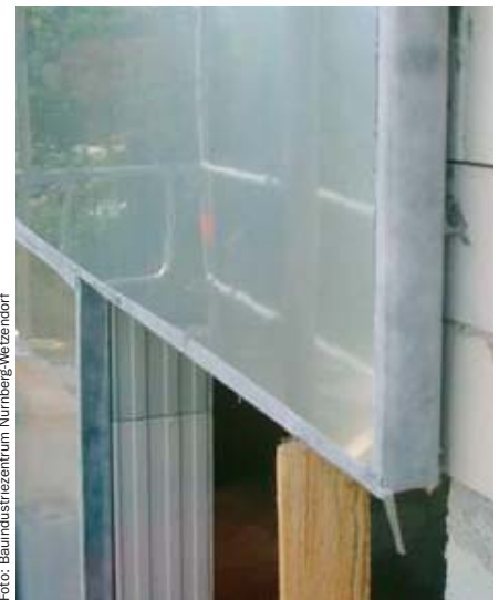
VIP-Dämmung im Bereich der Fenster
