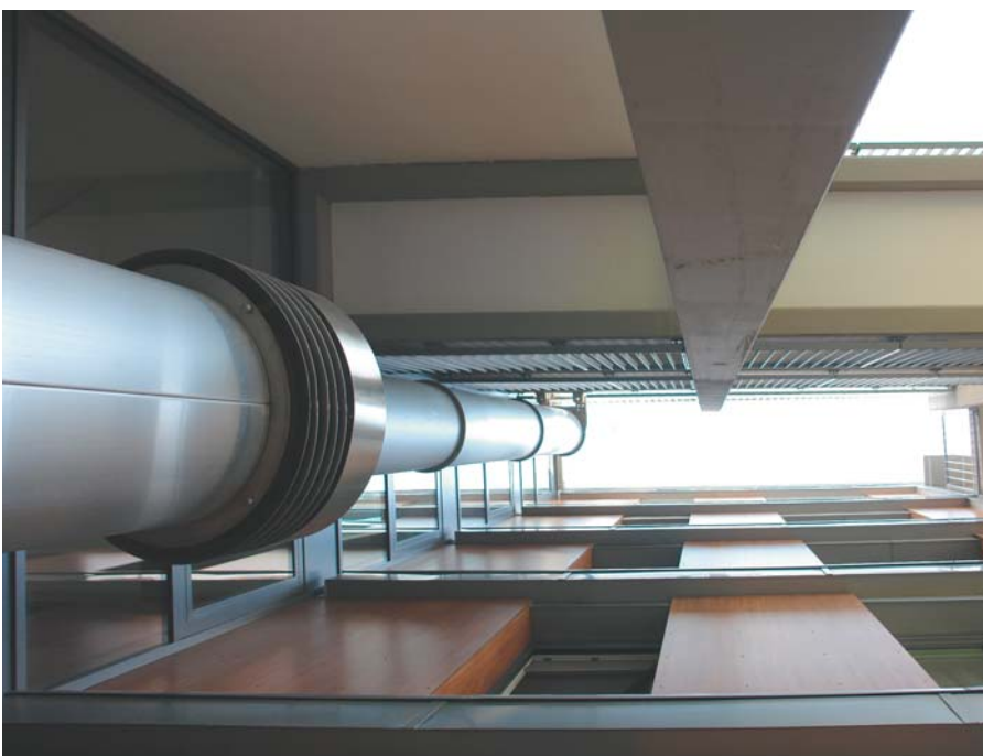
Frischluf- und Fortluftleitung der Lüftungsanlage
