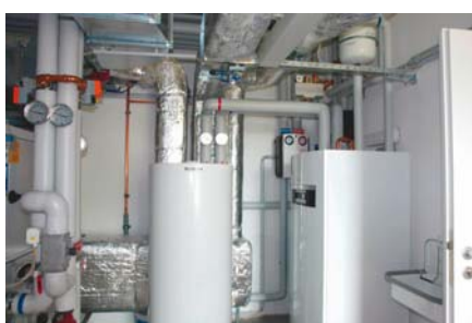
Heizung: Wärmepumpe
