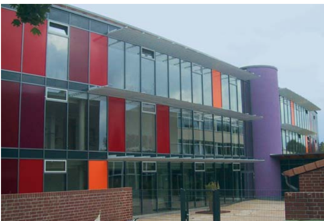
Eichendorff-Schule (2007), 31244 Peine, Außenwand: Kalksandstein mit WDVS Entwurf: Jörg Thienemann, 31224 Peine, in Zusammenarbeit mit Carsten Grobe, 30539 Hannover, www.architekt-thienemann.de
