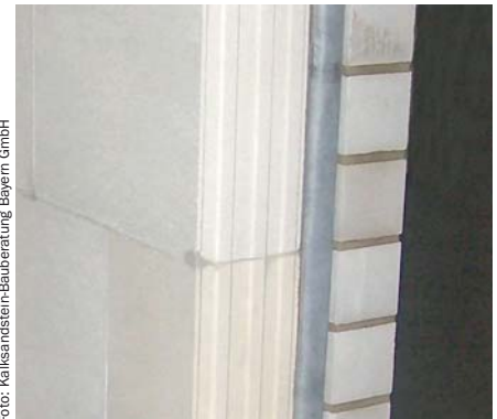
Anschluss Verblendmauerwerk
