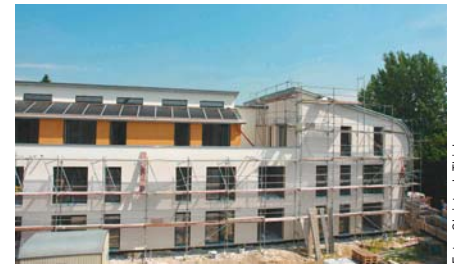
Ansicht Süd (Bauphase)
