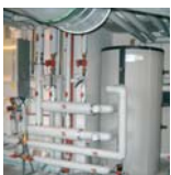
Gebäudetechnik im Passiv- und Plusenergiehaus
