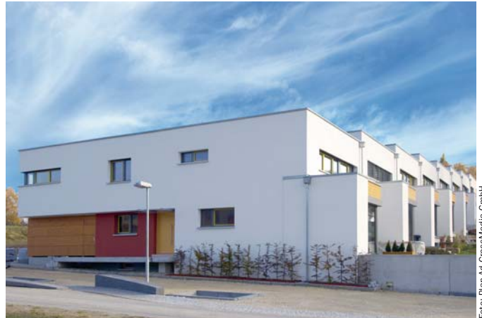
Sonnensiedlung (2007), 73730 Esslingen-Zell, Außenwand: Kalksandstein mit WDVS Entwurf: ASs Flassak & Tehrani, 70176 Stuttgart www.flassak-tehrani.de
