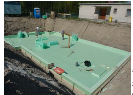
Dämmung unter Bodenplatte
