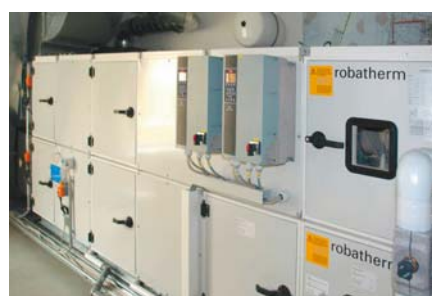
Lüftungsgerät
