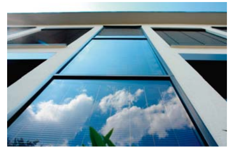
Fassadenintegrierte Solarthermieelemente
