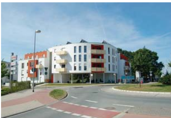
Erste Solarsiedlung in Münster „Das Passivhaus“ (2009), Außenwand: Kalksandstein mit WDVS Entwurf: ajp – architekten jörg petzold, 48161 Münster www.ajp-muenster.de
