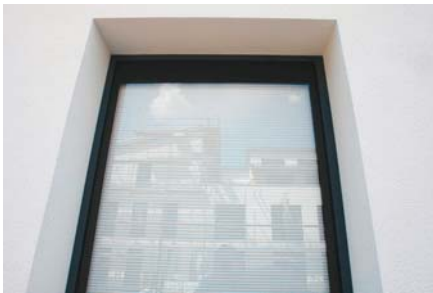
Holz-Alu-Fenster mit Dreischeibenverglasung und vorgesetzter Glasebene zur Integration des Verschattungselements
