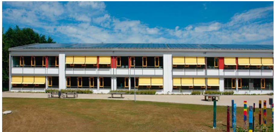
Südansicht – westlicher Bereich des Sekundarbereichs
