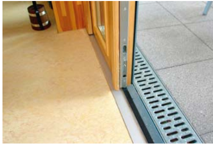
Einbau eines Fensters: barrierearme Schwelle
