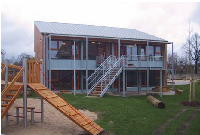
Kita Windröschenweg (2008), 30519 Hannover, Außenwand: Kalksandstein mit Wärmedämmung und hinterlüfteter Holzverschalung, Entwurf: Stadt Hannover, FB Gebäudemangement, 30449 Hannover, Ausführung: Mosaik Architekten BDA, 30167 Hannover, www.mosaik-architekten.de
