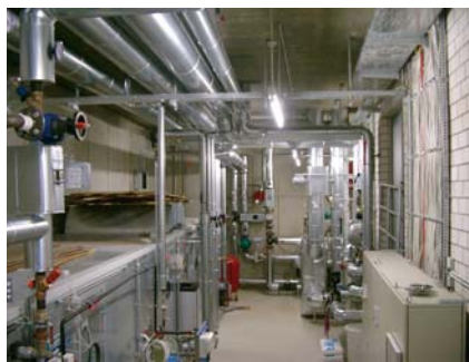
Lüftungszentrale für ein Bürogebäude mit über 5 000 m² Nutzfläche
