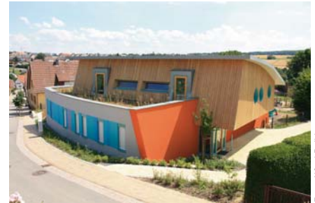
Ansicht von Nordwest
