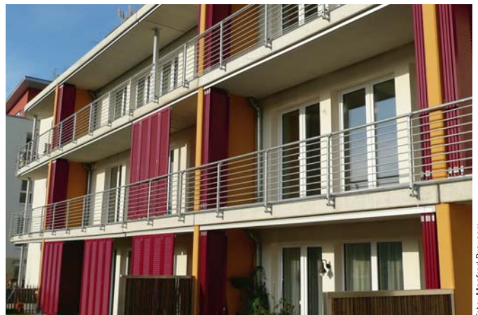
Mehrfamilienhaus (2007), 50733 Köln-Nippes, Außenwand: Kalksandstein mit WDVS Entwurf: MB PlanungsGmbH für passiv-solare Architektur, 50999 Köln, www.passiv-haus.de
