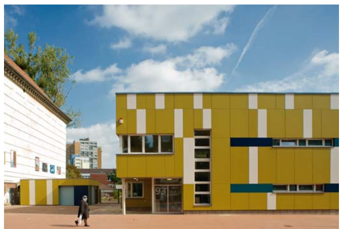
Kindertagesstätte Ricklinger Straße (2009), 30449 Hannover, Außenwand: Kalksandstein mit hinterlüfteter vorgehängter Fassade, Entwurf: vorrink wagner architekten bda, 30449 Hannover, www.vorrink-wagner.de
