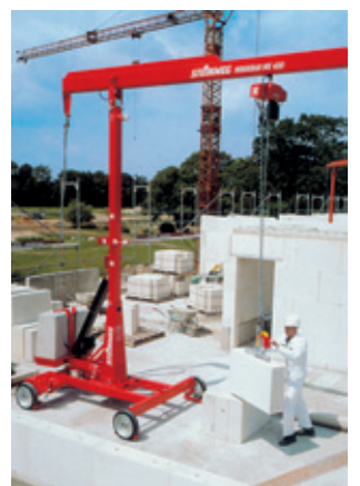
Versetzen von KS-QUADRO mit Hilfe eines Minikrans
