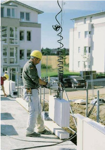
Bild 1. KS-QUADRO E beim maschinellen Vermauern
