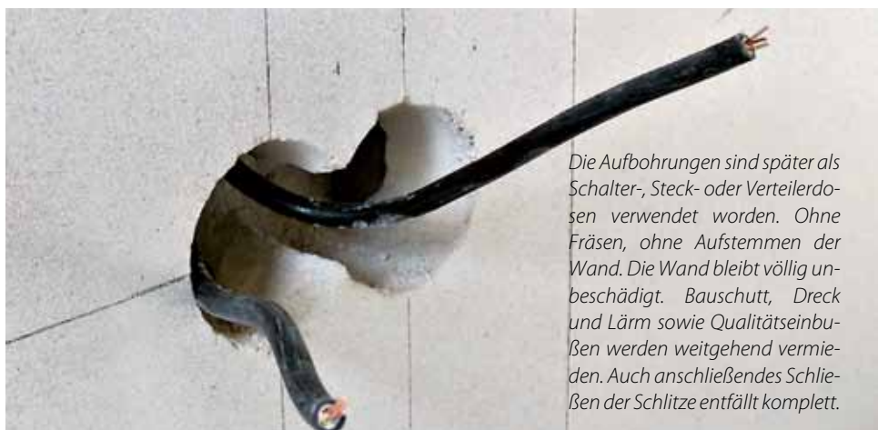
In den KS-QUADRO E Wänden befinden sich mittig im 12,5 cm Abstand von Wandkopf bis Wandfuß lot-rechte Installationskanäle. Alle 25 cm werden Temperiermodule in die Kanäle nach einem vorgegebenen Installationsplan gesteckt. Sie sind unsichtbar und liegen geschützt in der Wand – geschützt auch vor Beschädigungen durch Bohren oder Dübeln. Foto: KS-QUADRO Bausysteme GmbH
