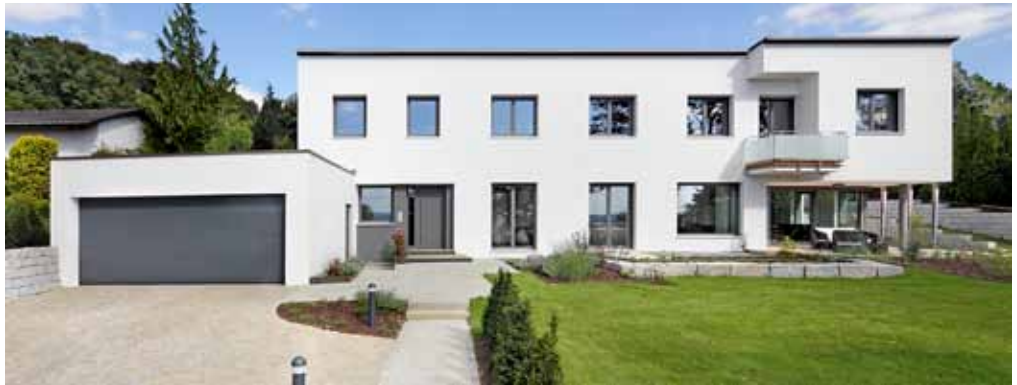
Die Zufahrt zu dem Haus ist seitlich platziert. Dadurch konnte ein großer Garten direkt vor dem Haus angelegt werden.
