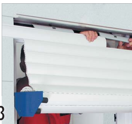
3 Rollladen in die Montagehilfe legen und ersten Stab in die Federbugel einschieben. Alternativ zweiteilige Federbugel zum anclipsen des Rollladens. Montage auch mit 2-geteiltem Federbugel möglich.
