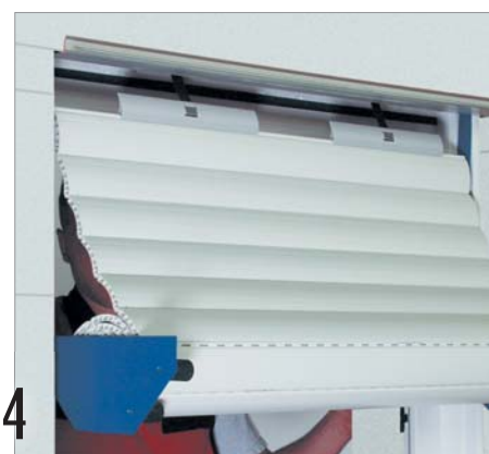
4 Rollladenbehang langsam hochziehen und von der Montagehilfe abrollen.
