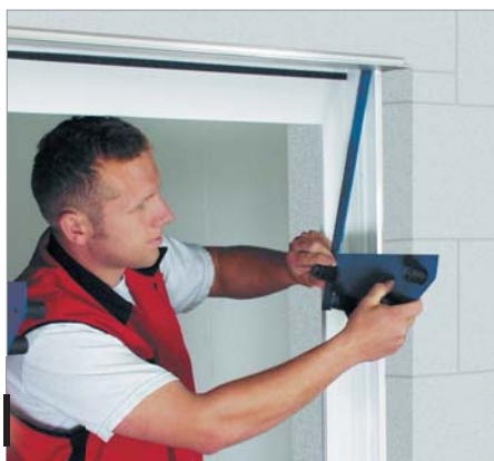
1 Beck+Heun „Ein-Mann-Montagehilfe“ in der Basisschiene einhängen.
