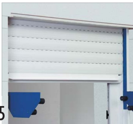
5 Schon hängt der der Rollladen im Kasten und die Montagehilfe kann entfernt werden.
