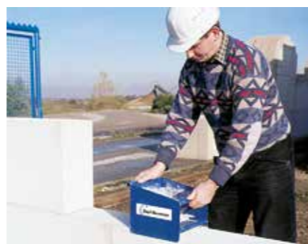
Mörtelauftrag mittels Dünnbettmörtel-Schlitten.
