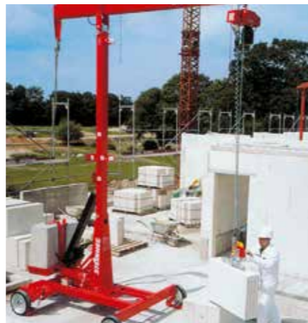
Durch den Einsatz von mobilen Versetzgeräten („Mini-Kränen“) können auch Ein-Mann-Teams KS-QUADRO verarbeiten.
