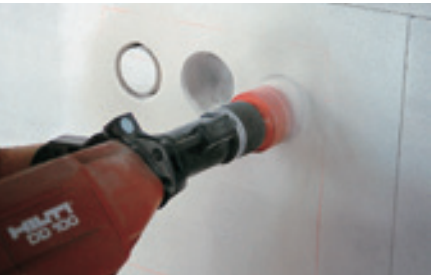
Kernbohrung für die Dosensetzung.
