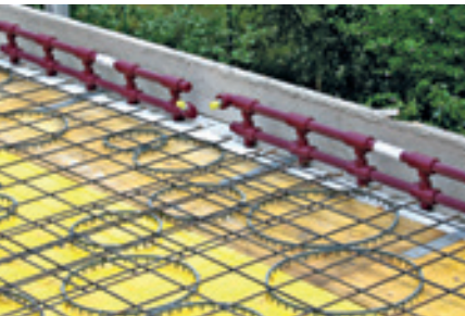
Deckenaufbau mit Schalung.
