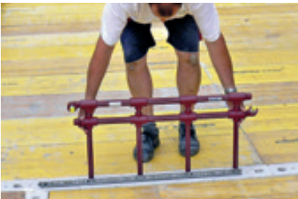
Einfädeln des Temperierungsmoduls.
