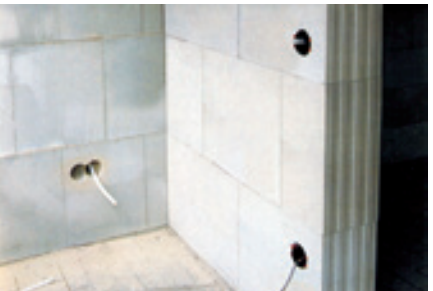
Die Wand wird geschont, die Arbeitszeit verkürzt: Installation mit KS-QUADRO E.
