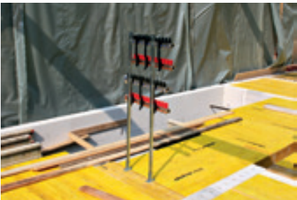
... an den Heizkreisverteiler.
