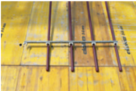
Die Einfädelhilfe von KS-QUADRO E.
