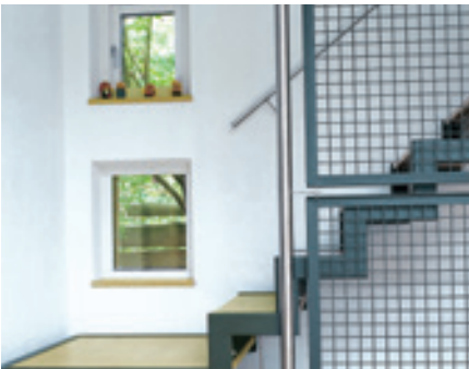
Verputzte Kellerwände geben dem Keller eine hochwertige Oberfläche.
