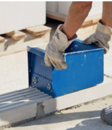
Mörtelauftrag mittels Schlitten.
