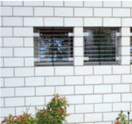
Kalksandstein-Sichtmauerwerk.
