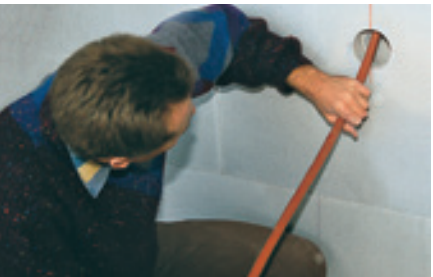
Einfädeln der Leerrohre oder Kabel.
