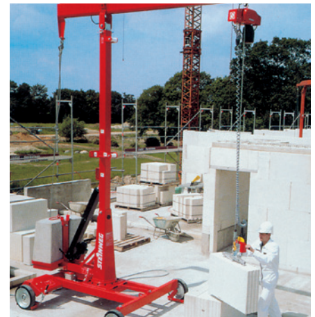
Durch den Einsatz von mobilen Versetzgeräten („Mini-Kränen“) können auch Ein-Mann-Teams KS-QUADRO verarbeiten.
