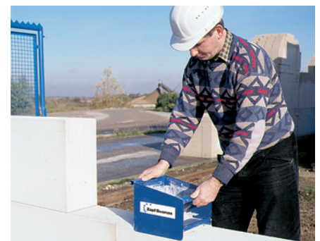
Mörtelauftrag mittels Dünnbettmörtel-Schlitten.
