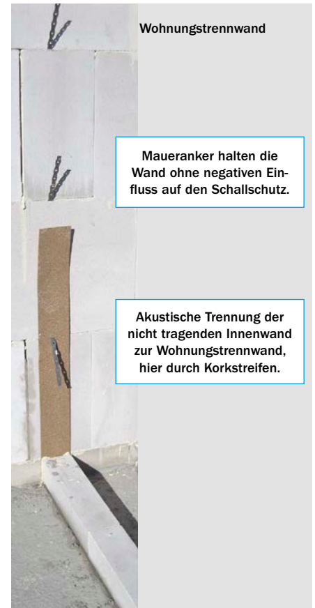
Bild 26: Akustische Trennung der nicht tragenden Innenwand ( m' < 200 \text{ kg/m}^2 ) zur Wohnungstrennwand
