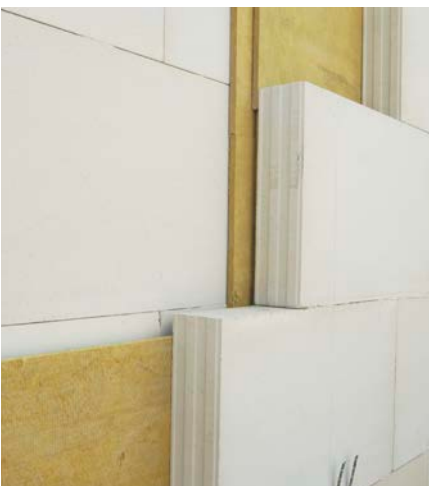
Bild 37: Dicht gestoßene Mineralfaserplatten Typ WTH vermeiden Schallbrücken.
