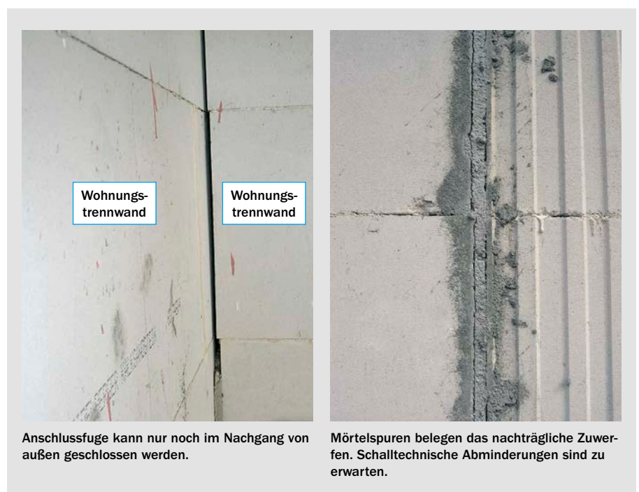
Bild 28: Nicht vermörtelter bzw. nachträglich vermörtelter Stumpfstoß
