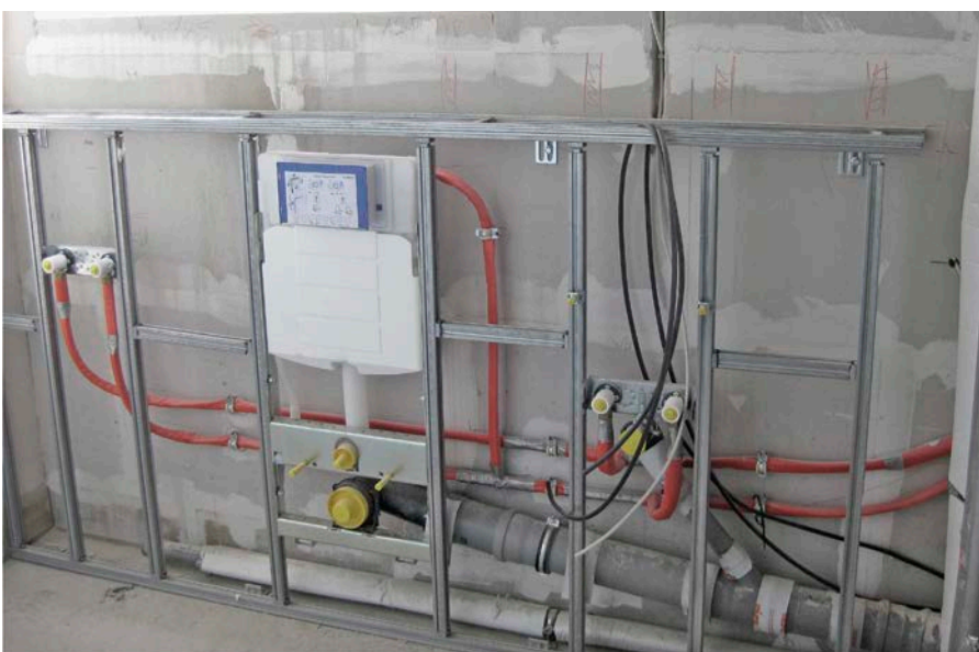
Bild 32: Vorwandinstallation mit verspachtelten Mauerwerksfugen
