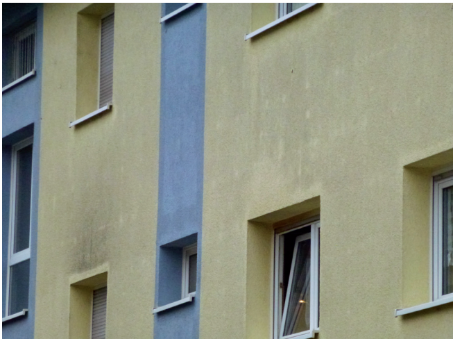
Bild 11–14: Die hellen Flecken auf den beiden linken Fotos stammen von Metalldübeln, die wärmer sind als die Dämmung
