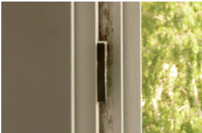
Bild 6: Schimmel am Fensterrahmen
