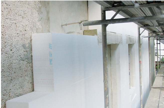
Bild 29: Wärmedämmverbundsystem mit Polystyrol
