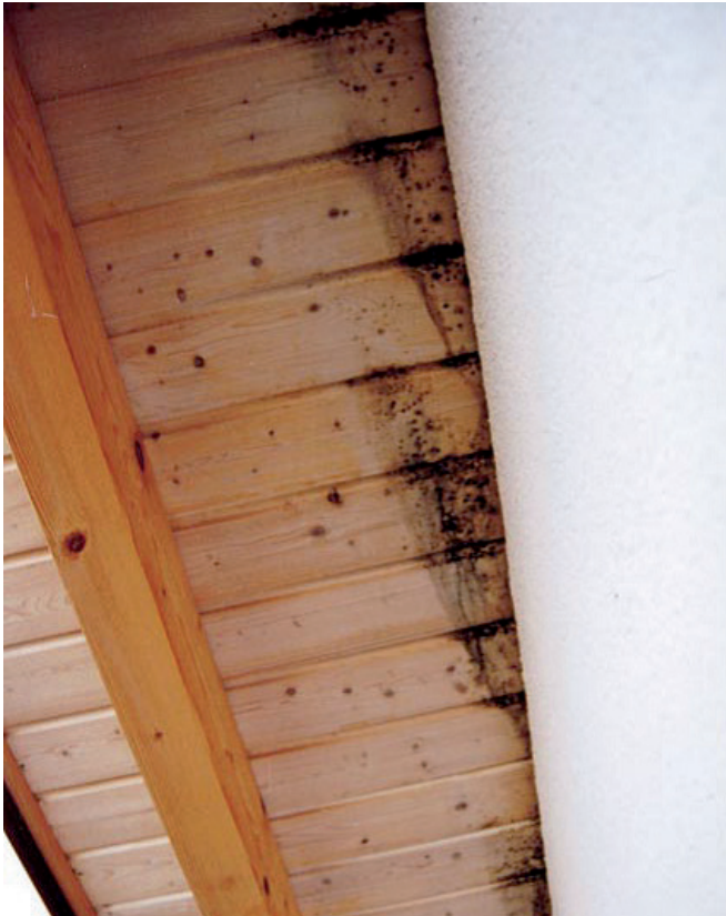
Bild 9: Dachüberstand außen an der Dachwohnung
