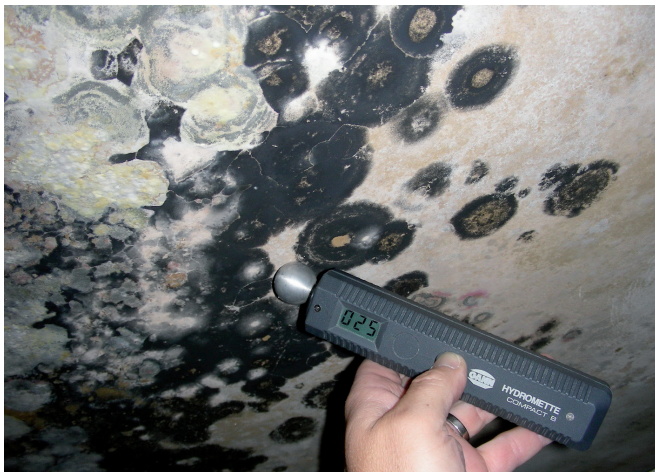
Bild 1–2: Typische Schimmelschäden
