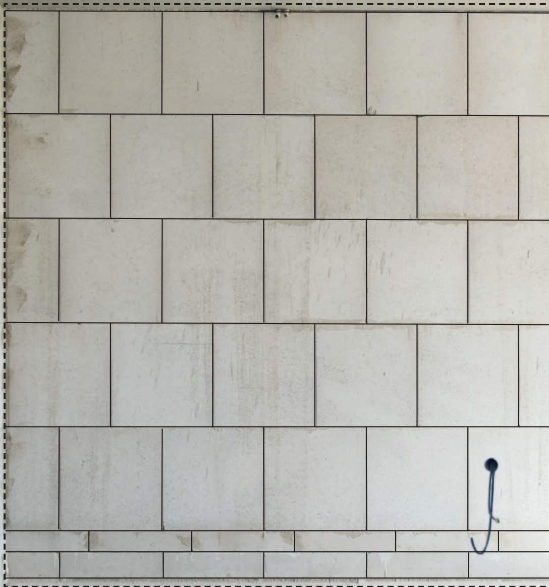
Auszug aus CAD-Wandoptimierung und vermauerte KS-QUADRO Wand.
