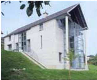
Mit Kalksandstein verblendete Außenwände haben eine hohe Lebenserwartung
