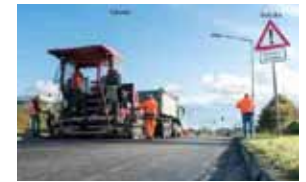
Recycelter Kalksandstein wird im Straßenbau verwendet
