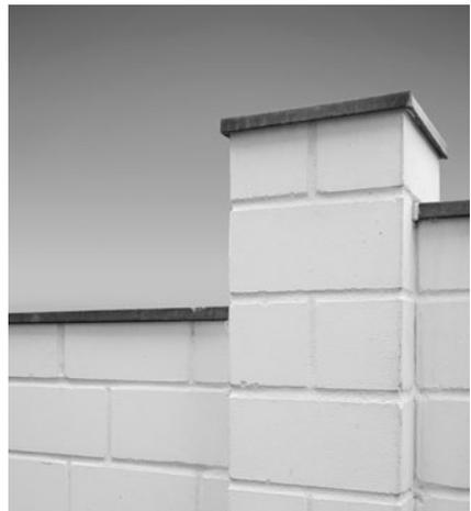
Bild 4/28: Gemauerter Pfeiler aus KS-Verblendern
