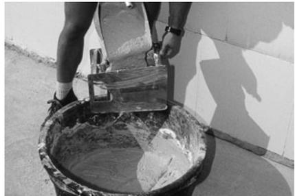
Bild 7/7: Der Dünnbettmörtel wird in den Dünnbettmörtelschlitten eingefüllt.
