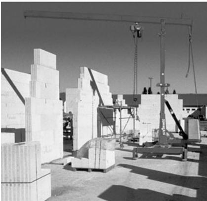
**Bild 5/10:** Das Versetzgerät lässt sich optimal verfahren, wenn es hinter den Steinstackeln aufgebaut wird.
