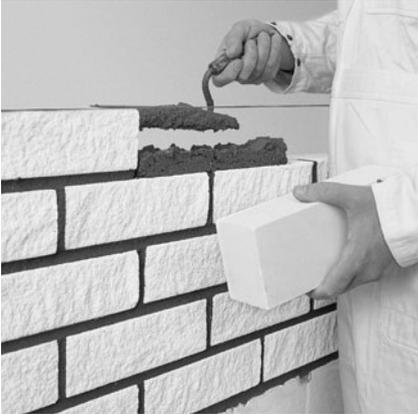
Bild 8/33: Das Mauerwerk wird vollfugig erstellt.
