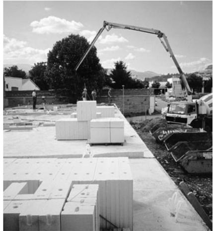
**Bild 5/6:** Das Absetzen der Stein stapeln erfolgt zweckmäßig auf Paletten oder Bohlengelege.
