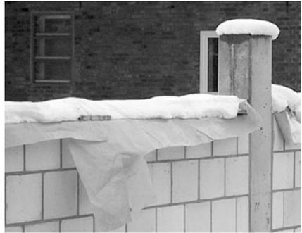
Bild 6/27: Das frische Mauerwerk ist vor Frost zu schützen, z.B. durch Abdecken mit Folie.
