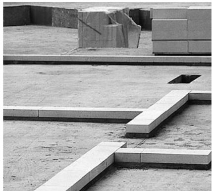
**Bild 5/13:** Das Anlegen der Kimmschicht erfolgt mit zeitlichem Vorlauf.
