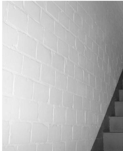
**Bild 9/6:** In untergeordneten Räumen darf das sichtbar bleibende Mauerwerk im Regelfall auch ein rustikales Aussehen haben.
