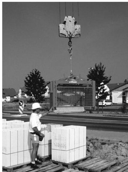
**Bild 5/15:** Der Transport auf der Baustelle mit dem Baustellenkran sowie geeigneten Steinkörben ist leicht und sicher.
