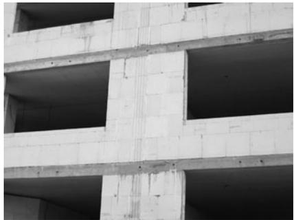
Bild 11/49: Durch die Außenwand durchgeführte Wohnungstrennwand
