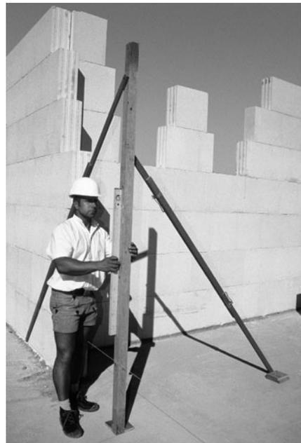
**Bild 7/1:** Das Ausrichten der Ecklehren erfolgt sorgfältig vor Beginn der Mauerarbeiten.
