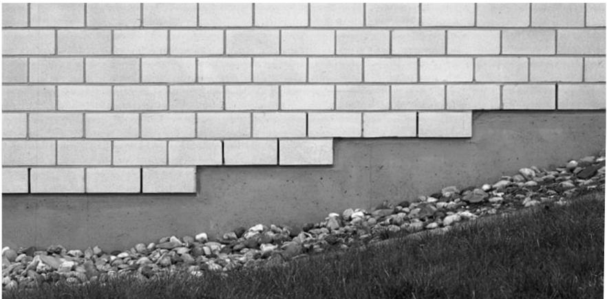
**Bild 8/44:** Kalksandstein-Verblendmauerwerk mit verputztem Sockel im Fußpunktbereich
