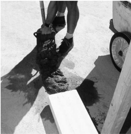
Bild 3/8: Die Kimmsteine werden in Normalmauermörtel der MG III versetzt.
