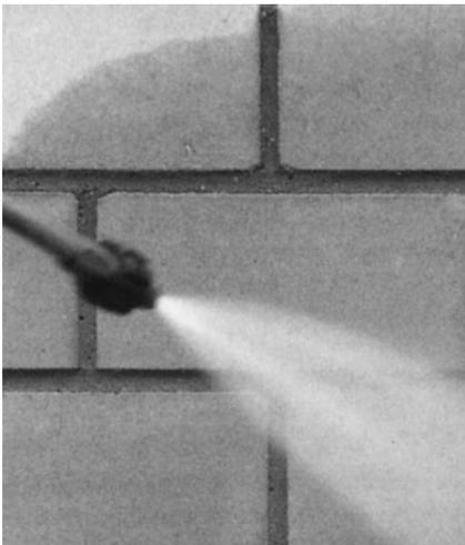
Bild 6/30: Reinigung mit Dampfstrahlgerät
