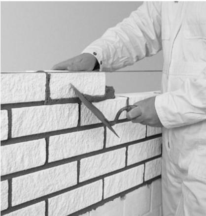
Bild 8/35: Der überquellende Mauermörtel wird mit der Kelle abgeschnitten.
