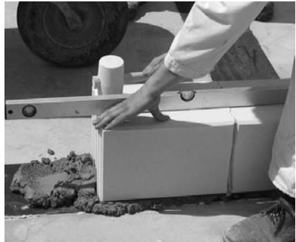
**Bild 3/3: Kontrolle der Ebenheit in Wandlängsrichtung**
