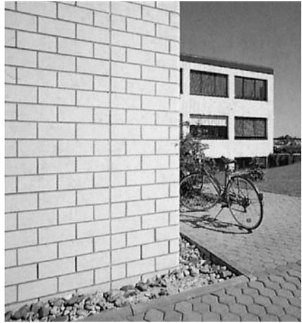
**Bild 8/45:** Beispiel für eine Fußpunktausbildung mit Kiesrandstreifen
