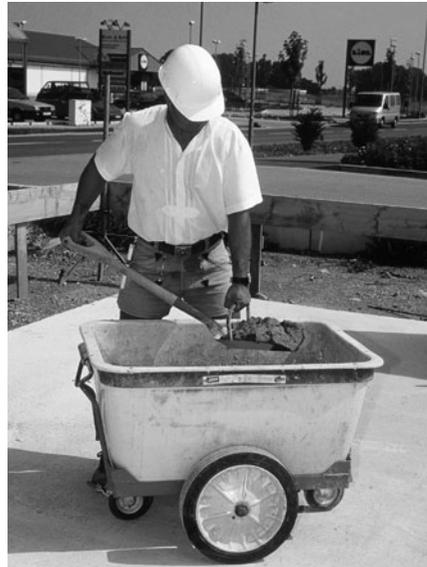
**Bild 5/14:** Der Kimmschichtmörtel lässt sich mit dem Mörtelwagen leicht zum Verarbei- tungsort transportieren.
