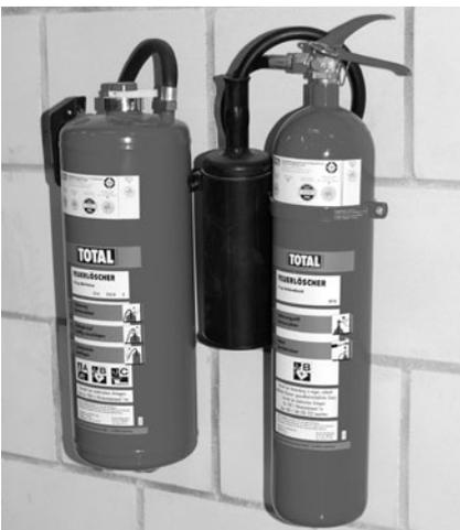
Bild 10/9: Befestigung von Feuerlöschern
