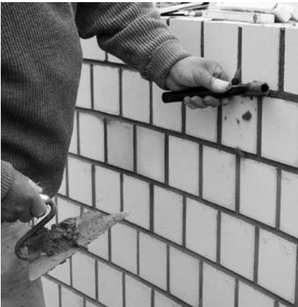
**Bild 3/7: Fugenglattstrich mit Normalmauermörtel, Verfugung im eigenen Saft**
