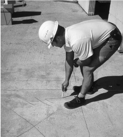
**Bild 5/5:** Anzeichnen von Stein stapeln und Mörtelkübeln am Verarbeitungsort
