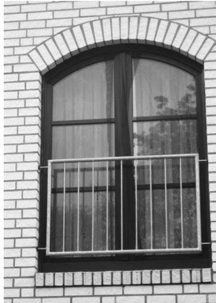
Bild 6/24: Ausführung eines Flachbogens
