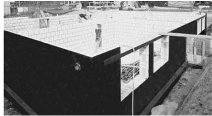
Bild 11/9: Kellerwände aus KS-Mauerwerk mit kunststoffmodifizierter Bitumenbeschichtung (KMB)
