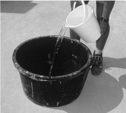
Bild 3/12: Das Wasser wird entsprechend der Verarbeitungsanweisung zuerst eingefüllt.
