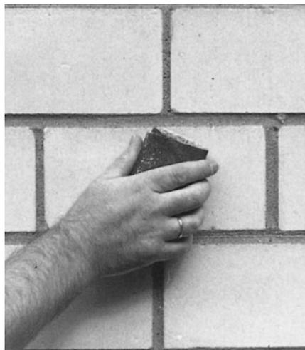
Bild 6/31: Reinigung mit Schleifpapier, feinste Körnung
