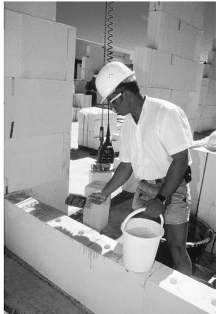
**Bild 6/29:** Bei starker Hitze ist das Vornässen der Mauersteine zu empfehlen.
