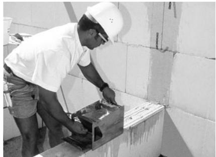
Bild 7/9: Der Auftrag mit dem Mörtelschlitten und der passenden Zahnschiene führt zu einem gleichmäßigen Mörtelauftrag.
