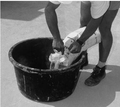
Bild 3/13: Der Werkmörtel wird in den Mauerkübel eingestreut.
