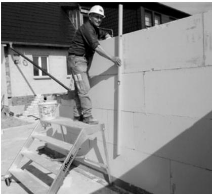
**Bild 5/12:** Ausreichender Arbeitsraum und der Einsatz von Rolltreppen erleichtern das Verarbeiten.
