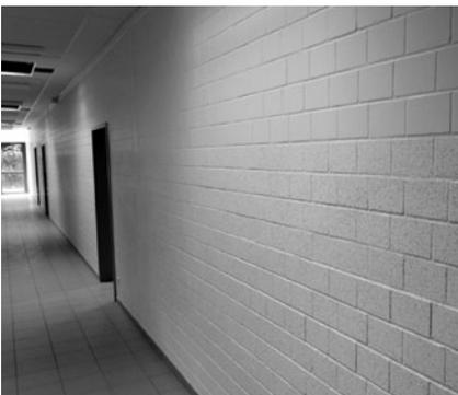
**Bild 8/3:** KS-Verblendmauerwerk, einfarbig gestrichen, tritt in der Fläche zurück.
