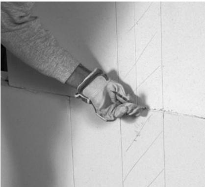
Bild 4/54: Vor dem Aufmauern der Querwand wird der Edelstahl-Flachanker aufgebogen.
