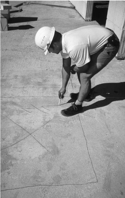
**Bild 6/4:** Das Anzeichnen der Steinpakete und der Mörtelkübel erfolgt rechtzeitig vor Anlieferung des Materials.
