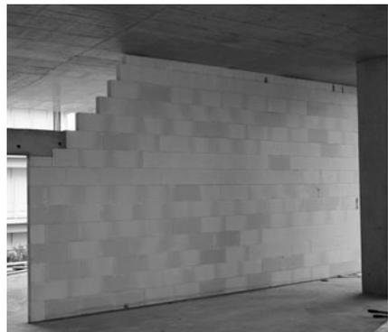
**Bild 11/37:** Nicht tragende Innenwand aus Kalksandstein-Bauplatten
