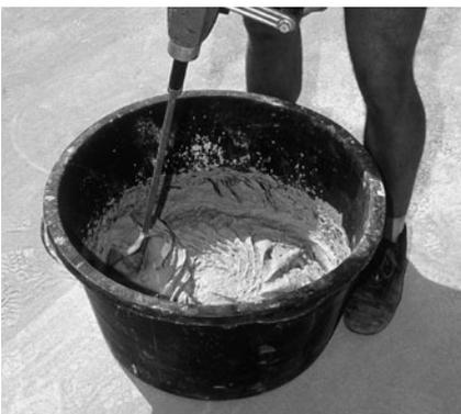
Bild 3/14: Der Mörtel wird nach Verarbeitungsanweisung durchgemischt.
