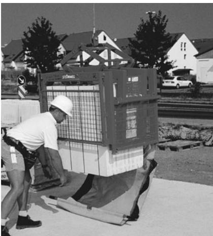
**Bild 5/7:** Absetzen der Steinpakete mit dem Baustellenkran auf der Zwischendecke
