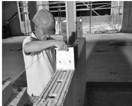
**Bild 3/17: Der Dünnbettmörtelauftrag erfolgt einfach und schnell mit dem Mörtelschlitten.**
