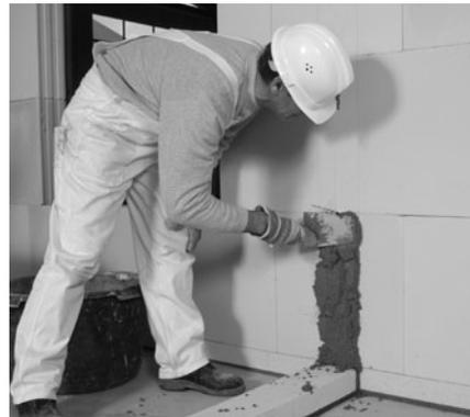
Bild 4/55: Beim Aufmauern der Querwand wird die Stumpfstoßfuge mit Mörtel aufge-
