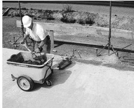
**Bild 7/11:** Der Einsatz einer verfahrbaren Mörtelwanne erleichtert und beschleunigt das Anlegen der Kimmsschicht zusätzlich.
