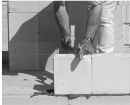
**Bild 3/2: Die Lage der Kimmschicht ist vor allem in Wandquerrichtung zu kontrollieren.**
