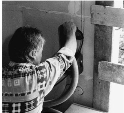
Bild 10/2: Vertikales Fräsen
