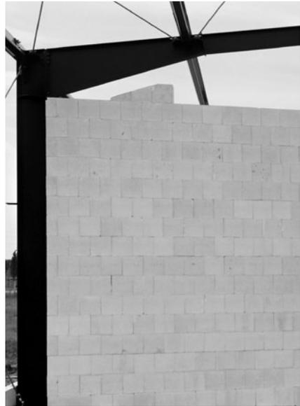
Bild 11/31: Kalksandstein-Mauerwerk als Ausfachung einer Stahlkonstruktion
