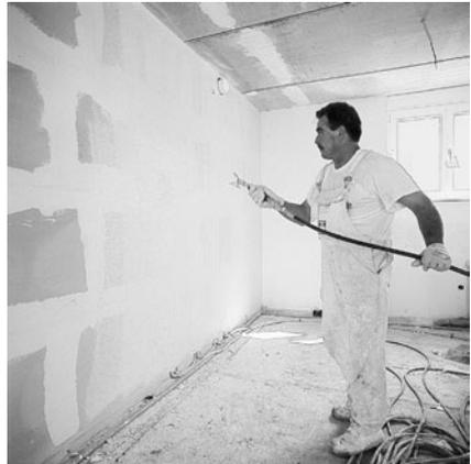
**Bild 9/9: Auftrag des Putzmörtels, Vorspachtelung nur bei Dünnlagenputz**
