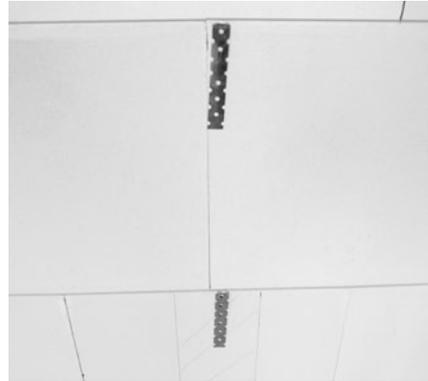
Bild 4/53: Aus Gründen der Arbeitssicherheit wird der hervorstehende Teil der Edelstahl-Flachanker abgewinkelt.
