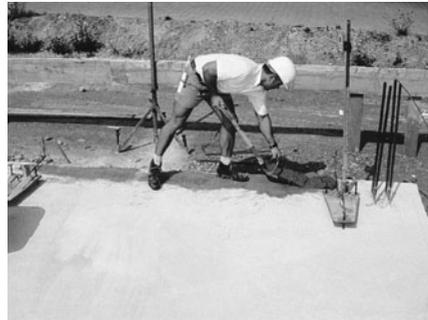
**Bild 7/10:** Vor dem Anlegen der Kimmsschicht wird der Untergrund gereinigt, die Dichtungsschlämme aufgebracht und nach Abtrocknen dann der Anlegemörtel (NM III) aufgetragen.
