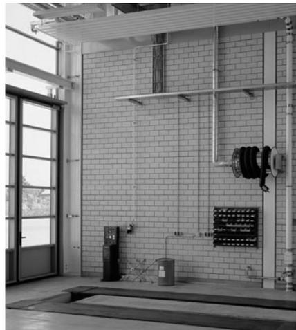
Bild 9/2: KS-Innensichtmauerwerk bietet helle und robuste Oberflächen im Gewerbe- und Industriebau.
