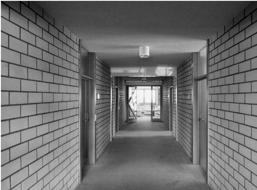
**Bild 11/58:** Im obersten Geschoss ist zu empfehlen, sehr lange tragende Wände vereinzelt durch geschosshohe Türöffnungen zu unterbrechen. Dies gilt besonders unter der Dachdecke.
