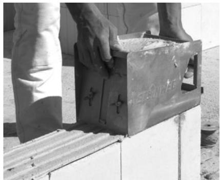
**Bild 3/4: Der Dünnbettmörtel wird mit dem Mörtelschlitten und der vom Dünnbettmörtel-Hersteller empfohlenen Zahnschiene aufgetragen.**
