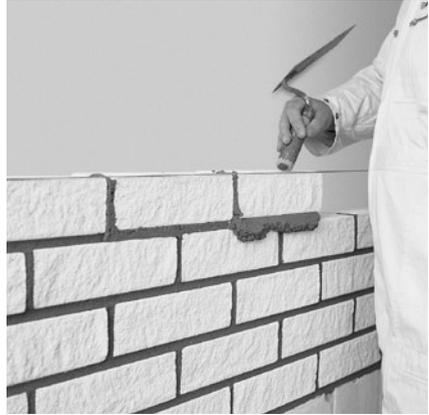
Bild 8/34: Die KS-Verblender werden fest angedrückt und nach Schnur ausgerichtet.
