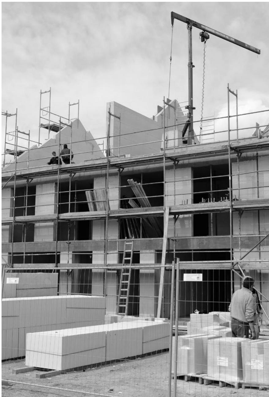
Bild 7/16: Bau einer Reihenhuisanlage mit Kalksandstein-Planelementen
