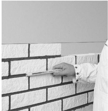
Bild 8/36: Nach dem Ansteifen werden die Fugen mit einem abriebfreien Schlauchstück angedrückt und verdichtet.
