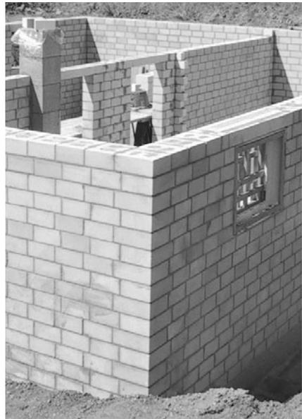
Bild 4/15: Eckausbildung mit Kalksandsteinen mit Normalmauermörtel
