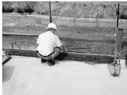
**Bild 7/12:** Anschließend wird der Mörtel sauber abgezogen. Der Einsatz einer Justierhilfe beschleunigt das Anlegen der Kimmsschicht.
