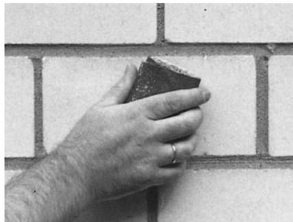
**Bild 8/38: Reinigung mit Schleifpapier, feinste Körnung**
