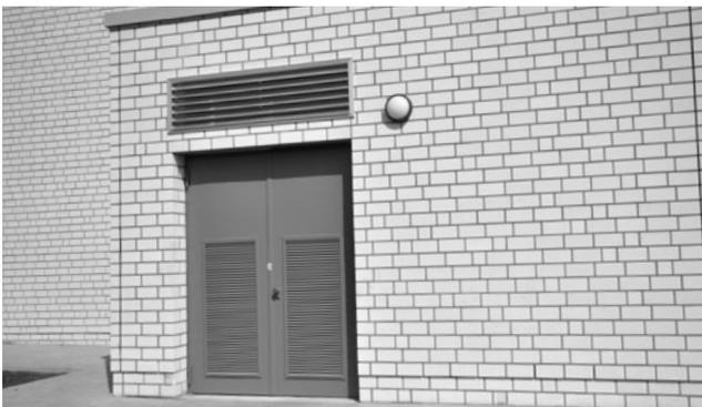
**Bild 1/2: Die Maßordnung ist bei Verblendmauerwerk von besonderer Bedeutung.**
