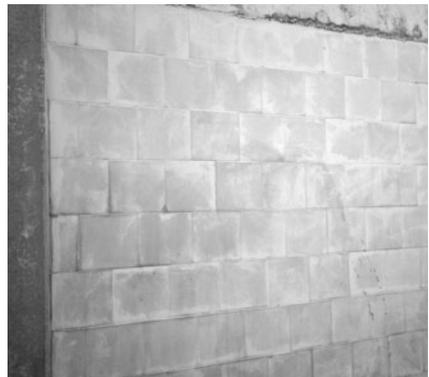
Bild 9/8: Bei geringen optischen Anforderungen eignen sich KS-Plansteine mit einer Verspachtelung der Fugen.
