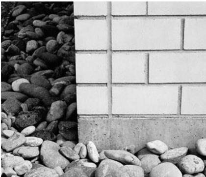
Bild 8/50: Dehnungsfuge an einer Gebäudeecke mit spritzbarem Dichtstoff
