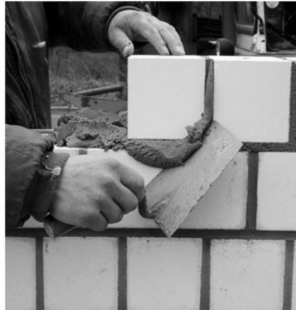
Bild 3/5: Verarbeitung von Normalmauermörtel
