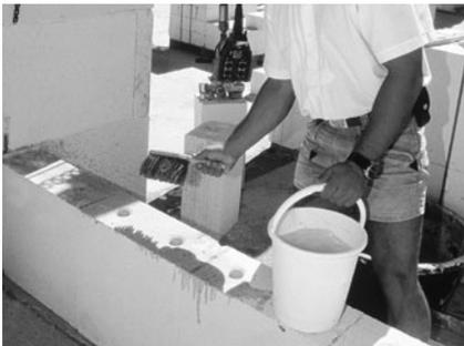
Bild 7/8: Bei sehr trockenen Steinen sind diese vorzunässen.
