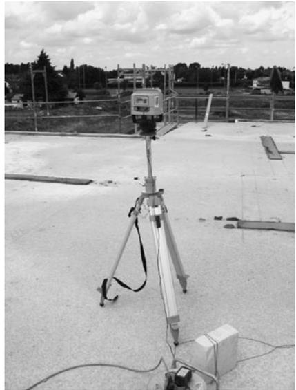
Bild 7/2: Das Schichtmaß wird mit Hilfe eines Hochbaulasers angezeichnet.
