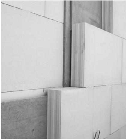
Bild 11/54: Dicht gestoßene Mineralfaserplatten Typ WTH vermeiden Schallbrücken.
