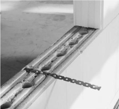
Bild 4/52: Beim Aufmauern wird der Edelstahl-Flachanker im Mörtelbett eingelegt.
