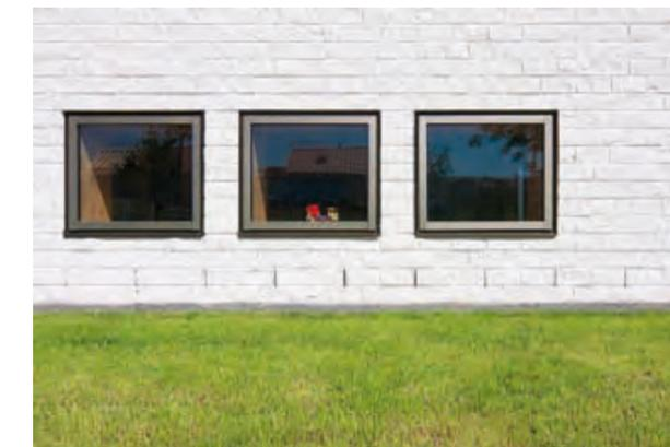
Das weiße, bruchraue 2DF-KS-Sichtmauerwerk steht in einem spannungsvollen Struktur- und Farbkontrast zur horizontalen Holzverschalung und prägt die äußere Erscheinung des Baukörpers. Die Fenster der Schlaf- und Kleingruppenräume sind tiefer gelegt, damit die Kleinen einen freien Blick nach draußen haben.
