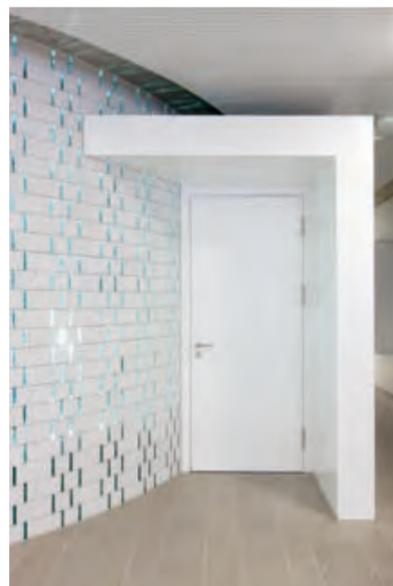
Die helle Ausstrahlung und die hohe Oberflächenqualität des weißen Kalksandstein-Sichtmauerwerks tragen zur Harmonie und Ausgewogenheit des Raumes bei. Zwischen den Steinen sind – quasi als Stoßfuge – ca. 1,5 cm dicke Glaselemente eingelassen, deren Schnittflächen grünlich schimmern. Es ist eine geschlossene Wand entstanden, die nicht abgeriegelt wirkt, sondern offen, transparent und hell.
