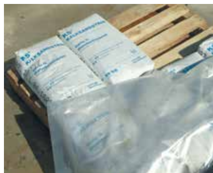
Bild 2: Werk-Trockenmörtel ist vor Witterungseinflüssen zu schützen.
