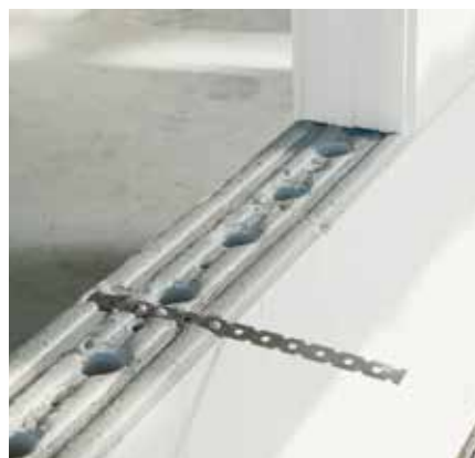
Bild 35: Mörtelbett mit Edelstahl-Flachanker
