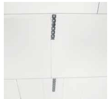
Bild 36: Abgewinkelte Edelstahl-Flachanker (Bauphase) in Achse der anschließenden Wand
